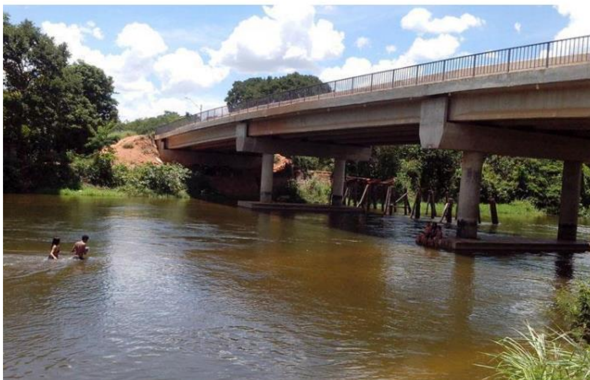
Figura 21 - Nova ponte em concreto armado, sobre o Rio de Ondas – Barreiras-BA, acesso à UFOB, 2012
