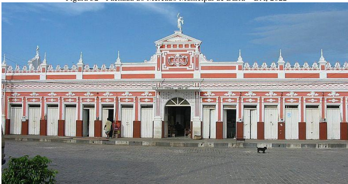
Figura 32 - Fachada do Mercado Municipal de Barra – BA, 2022
