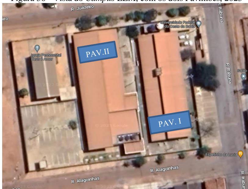
Figura 36 - Vista do Campus LEM, com os dois Pavilhões, 2023
