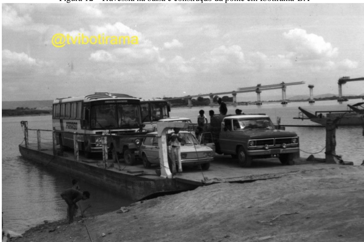
Figura 12 - Travessia na balsa e construção da ponte em Ibotirama-BA
