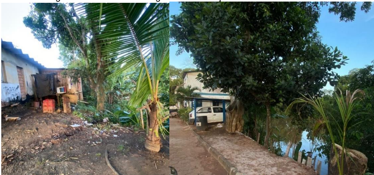
Figura 29 - Trechos ao longo do Rio Aliança. Palafitas não removidas
