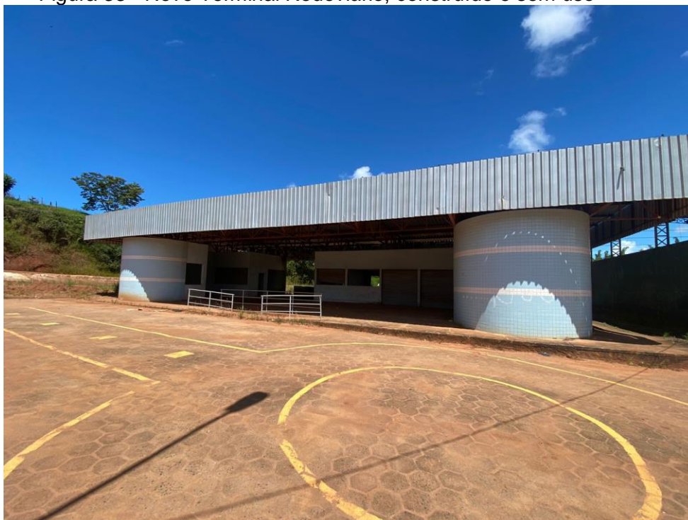
Figura 33 - Novo Terminal Rodoviário, construído e sem uso
