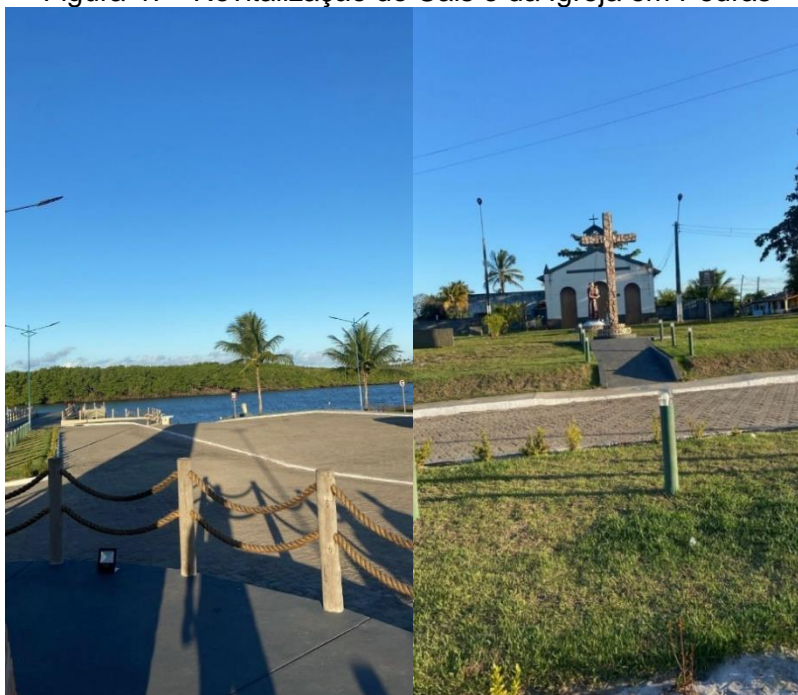
Figura 47 - Revitalização do Cais e da Igreja em Pedras
