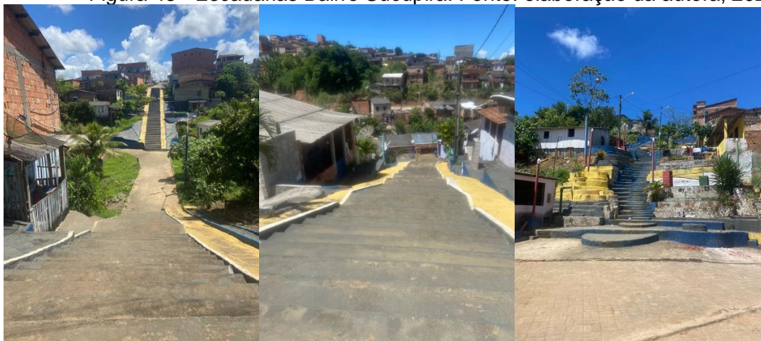
Figura 43 - Escadarias Bairro Sucupira. Fonte: elaboração da autora, 2023
