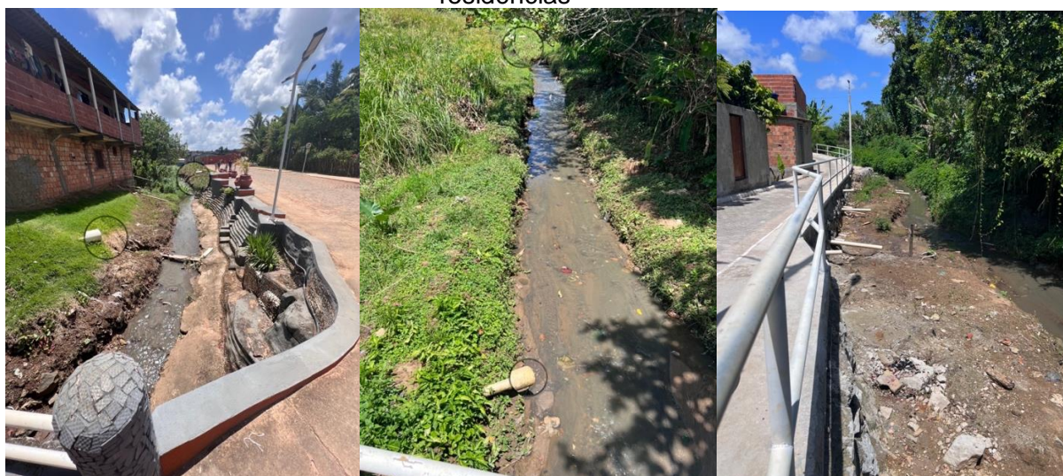
Figura 28 - Trechos ao longo do Ribeirão do Tony, localizado no Bairro Marcel Ganem, sendo possível observar durante todo o percurso despejo em local aberto dos dejetos das residências
