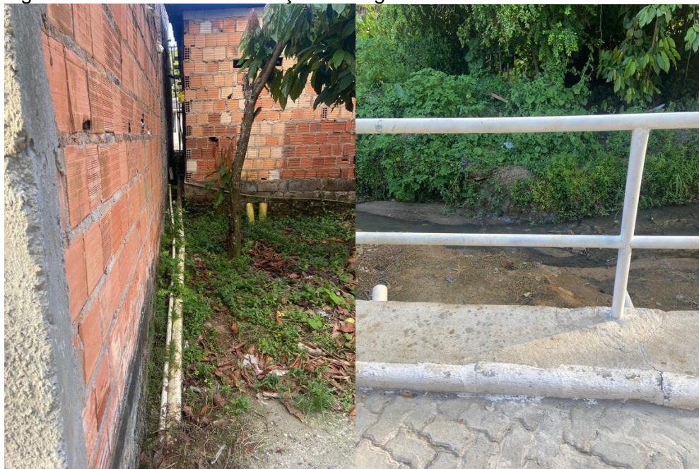
Figura 36 - Caminho da tubulação de esgoto e o escoamento no Ribeirão do Tony
