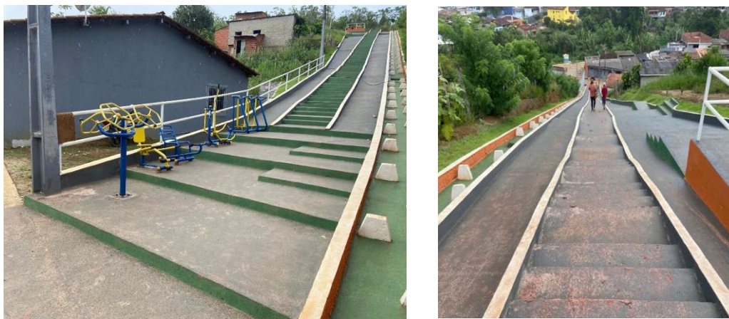
Figura 41 - Escadaria que liga o Bairro Marcel Ganem ao Bairro Sucupira
