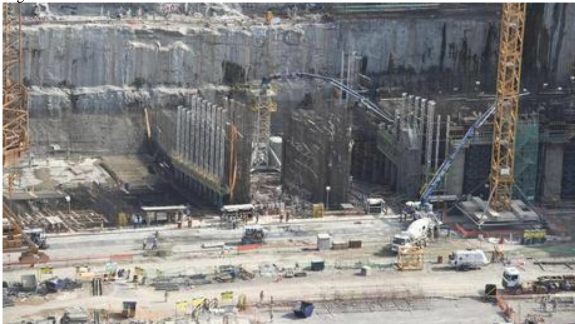
Figura 1 - Vista do alto do canteiro de obras da Usina de Belo Monte
