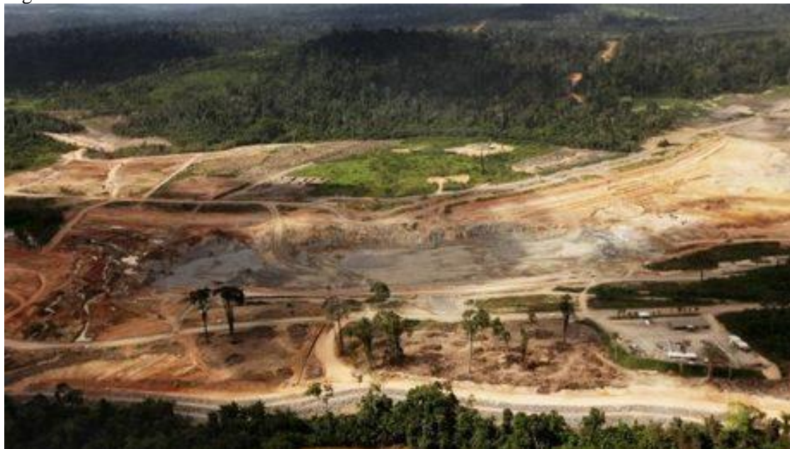
Figura 2 - Canteiro de obras da Usina de Belo Monte
