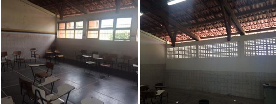
Figura 9 - Substituição de janelas (esquerda) por cobogó (direita), na sala “A”
