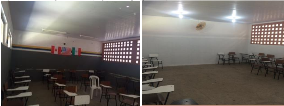
Figura 10 - Cor de parede antes (esquerda) e após pintura (direita) na sala “B”
