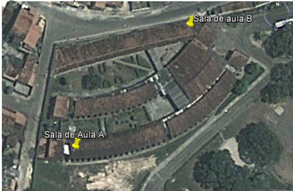
Figura 1 - Localização das salas de aula “A” e “B” na unidade escolar analisada
