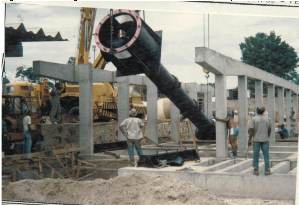
Figura 17 - Montagem de bomba 01 do sistema de recalque do Formoso A
