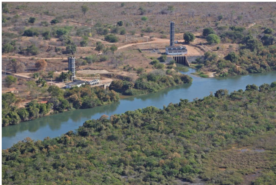
Figura 44 - Visão aérea das estações de bombeamento principais do Projeto Formoso
