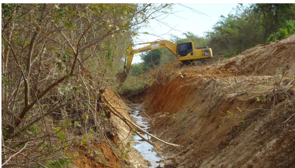
Figura 49 - Execução dos Serviços de Construção dos Drenos no Projeto Formoso
