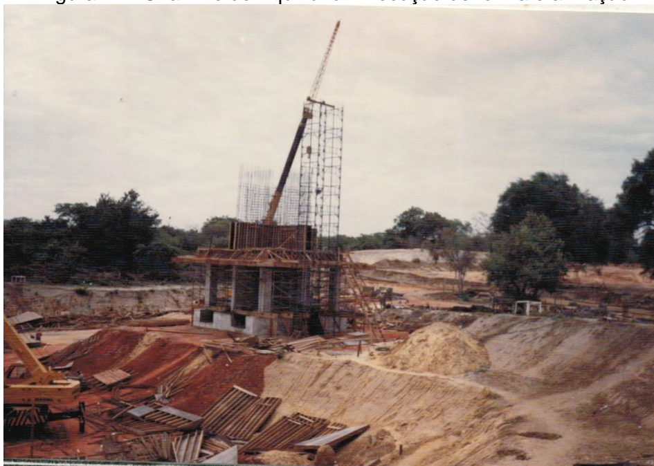
Figura 12 - Chaminé de Equilíbrio. Execução de forma e armação
