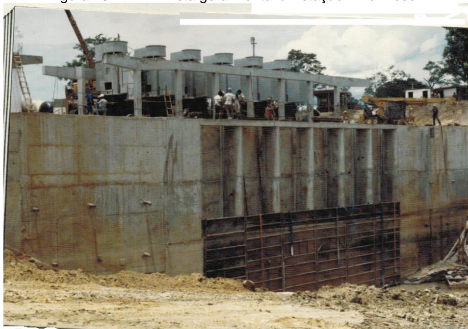
Figura 18 - EBP - Vista geral frontal à Estação – Formoso A
