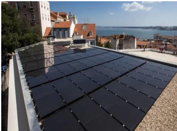
Figura 29 - Cobertura do Parque de Estacionamento do Chão do Loureiro, Portugal
