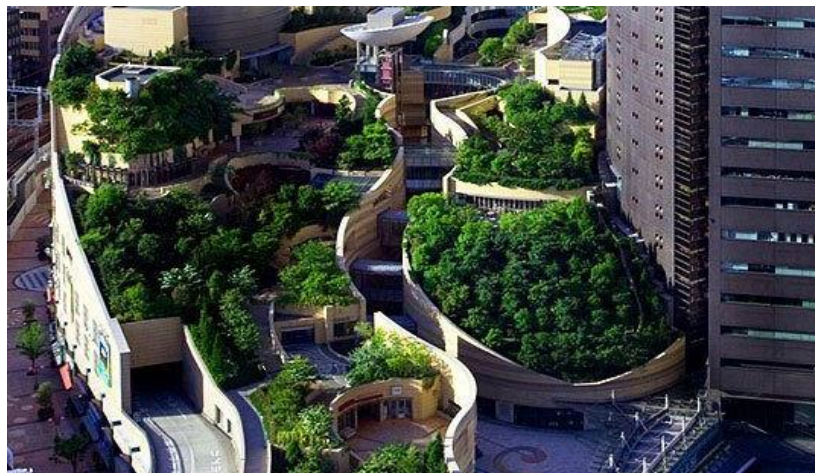
Figura 22 - Cobertura intensiva Namba Parks
