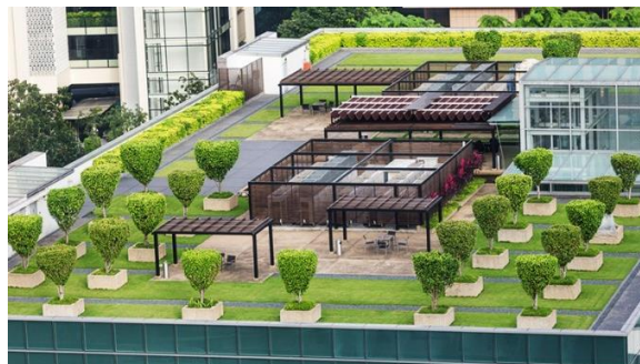
Figura 19 - Cobertura verde em edificação
