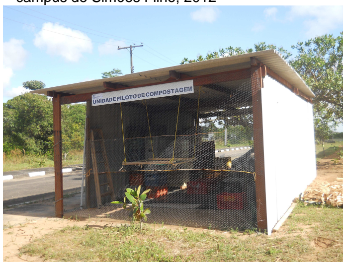
Figura 13 - Galpão da Unidade Piloto de Compostagem – IFBA campus de Simões Filho, 2012
