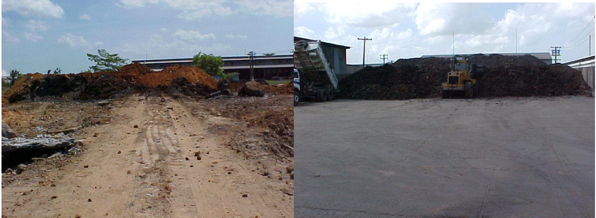
Figura 21 - Progresso do desmonte do landfill e depósito temporário em pátio pavimentado.
