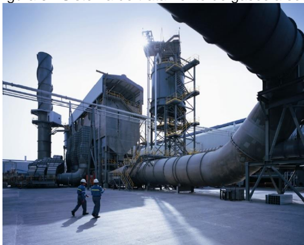
Figura 3 - Sistema de tratamento de gases a seco
