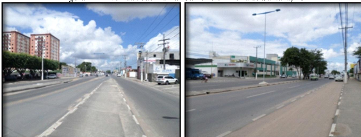
Figura 12 - Avenida João Durval Carneiro em Feira de Santana, 2014
