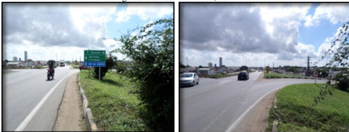
Figura 32 - Vista da BR-101, 2014
