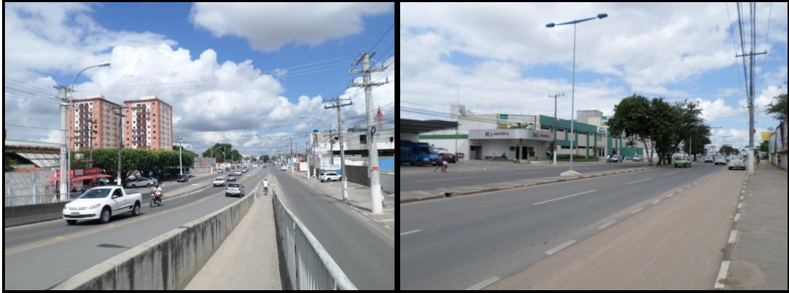
Figura 56 - Avenida João Durval Carneiro, 2014
