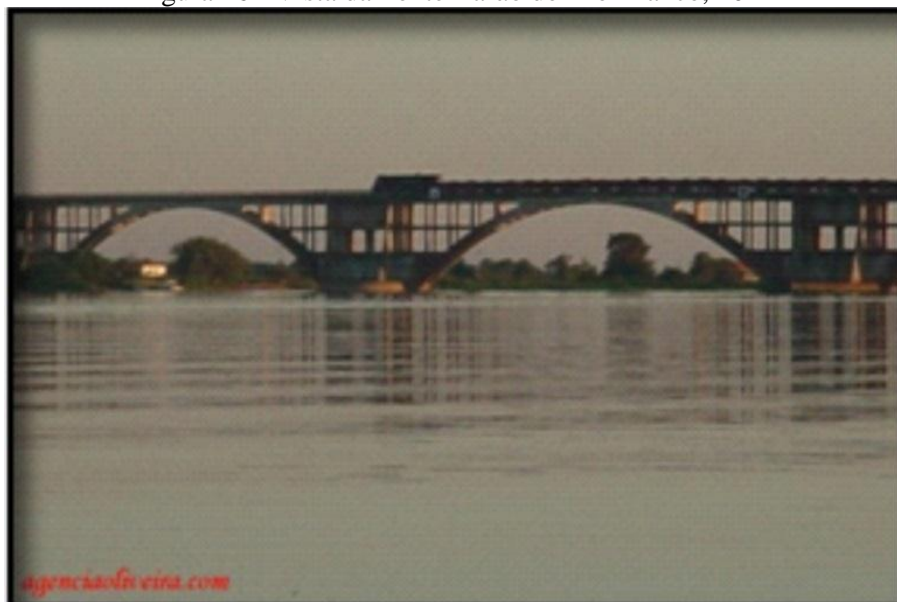
Figura 26 - Vista da Ponte Barão do Rio Branco, 2014
