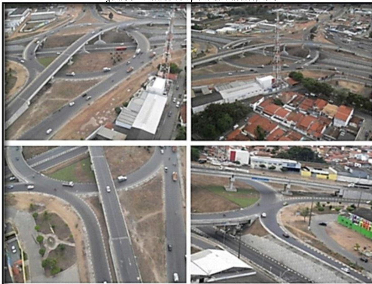
Figura 36 - Vista do complexo de viadutos, 2013
