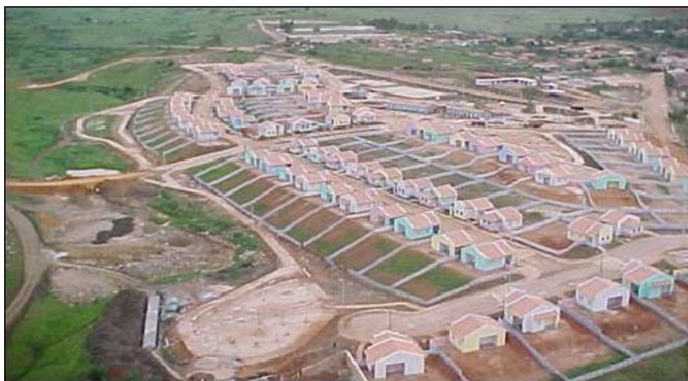
Figura 29 – Visão geral do novo bairro Fonte: Itapebi Geração de Energia S/A
