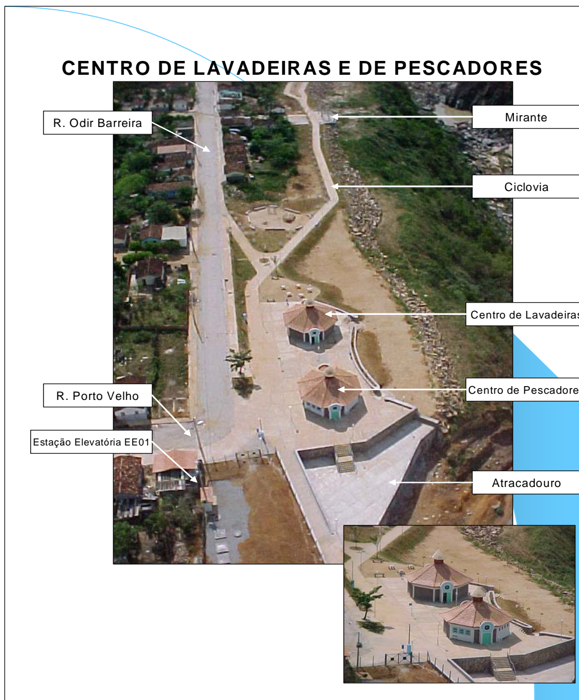
Figura 24 – Obras de infra-estrutura em Salto da Divisa Fonte: Itapebi Geração de Energia S/A
