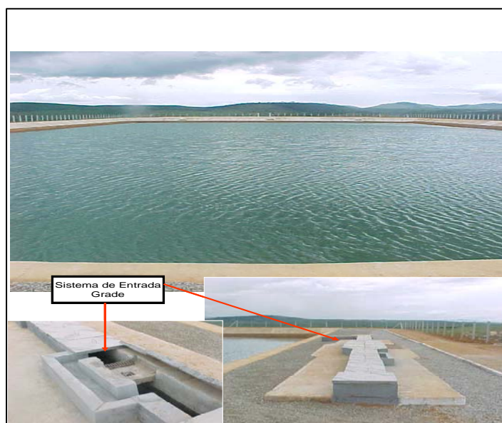
Figura 28 – Lagoa de estabilização Fonte: Itapebi Geração de Energia S/A
