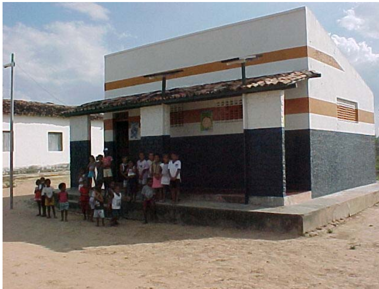
Módulos instalados em local de sombra
