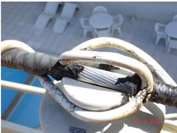
Figura 9 - Condutor protegido instalado na Avenida Manuel Dias da Silva Nota: Elaboração própria.
