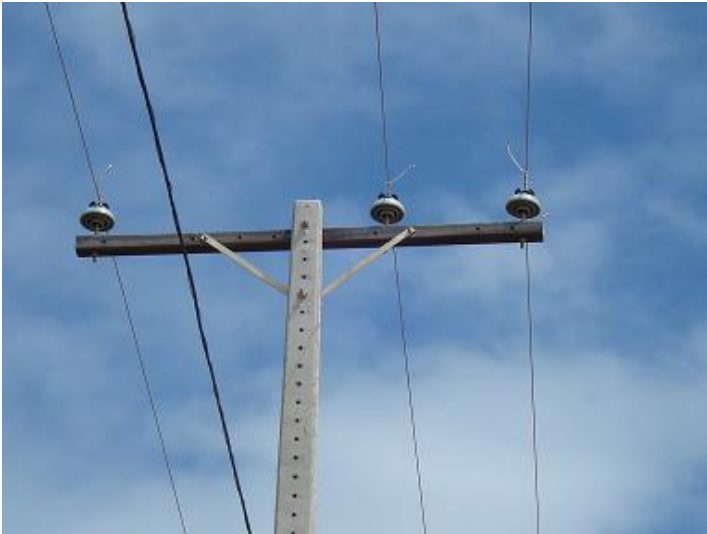
Figura 7 - Conductor primário de alumínio nu Nota: Elaboração própria.
