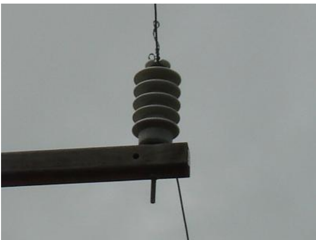
Figura 4 - Isolador de pedestal também utilizado na orla marítima Nota: Elaboração própria.
