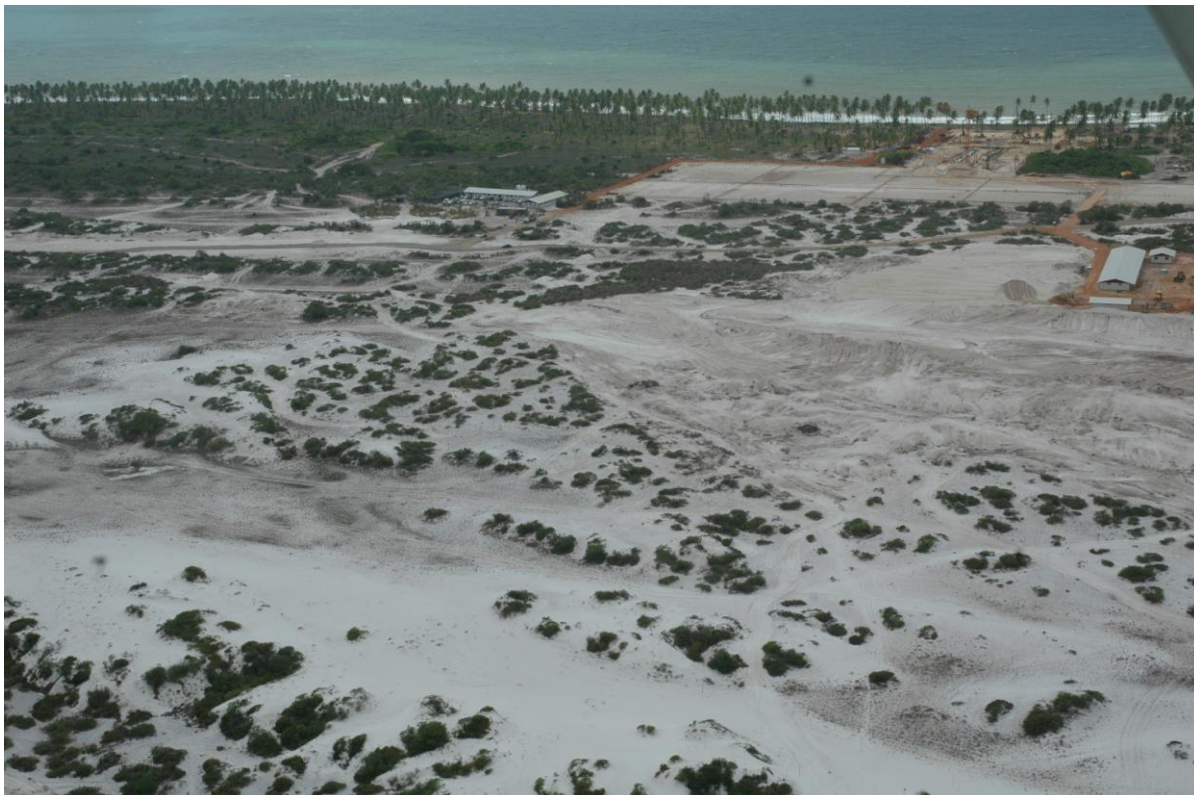
Figura 36 - Foto Aérea da construção civil do Hotel Iberostar Bahia em Praia do Forte/BA. Fonte: Arquivo pessoal de Adriano Paiva – 2008.
