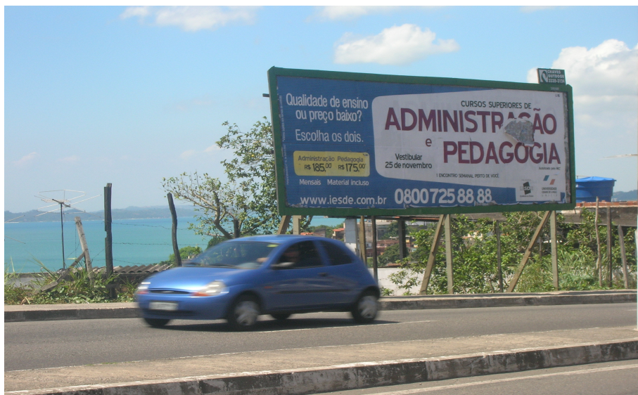
Figura 28 - Outdoor na Av. Suburbana: estrutura de sustentação precária quando comparada com as das placas da região central da cidade Nota: Elaboração da própria autora (2007).
