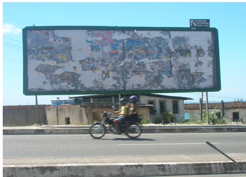
Figura 34 - Estrutura da placa instalada na avenida Suburbana foge ao padrão daquelas instaladas na região central da cidade Nota: Elaboração da própria autora (2007).
