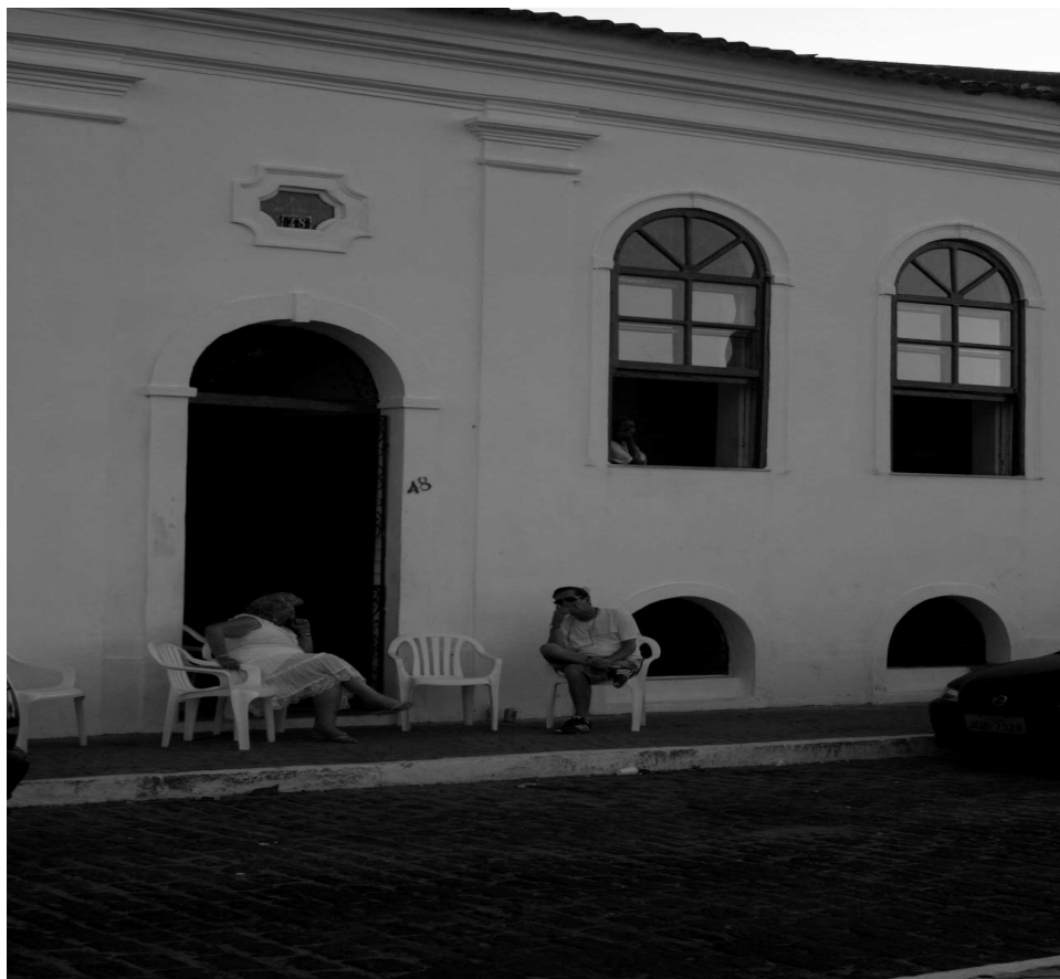
Figura 11 - Detalhe da arquitetura do Casarão 36 da Ponta de Humaitá - 2006 Foto: Mariana Gadelha (2006).
