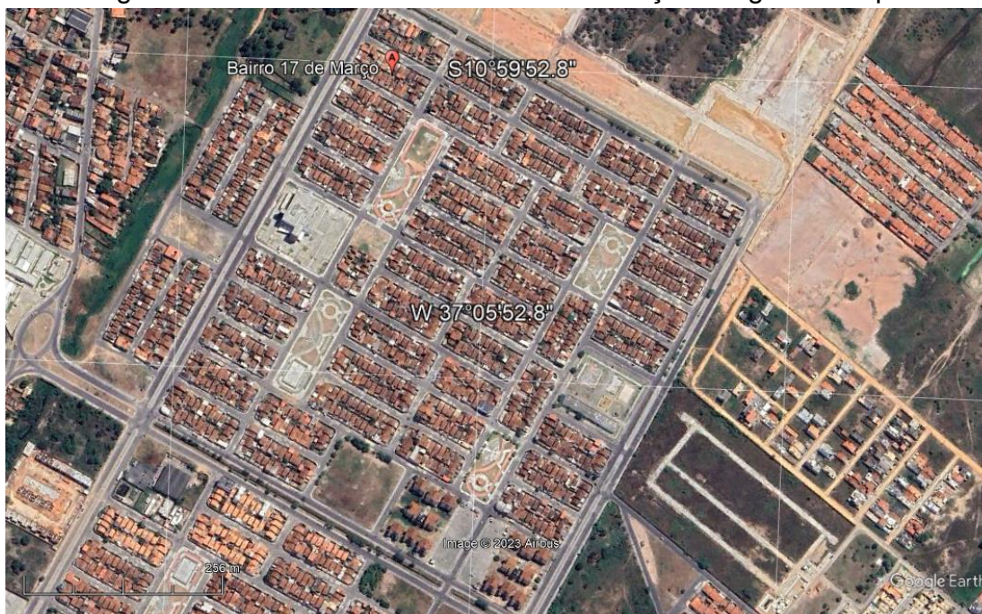
Figura 16 – Vista aérea do bairro 17 de Março – Segunda etapa
