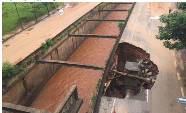
Figura 3.3 – Vista dos efeitos da enchente ocorrida ao longo do rio Arrudas – Belo Horizonte/MG
