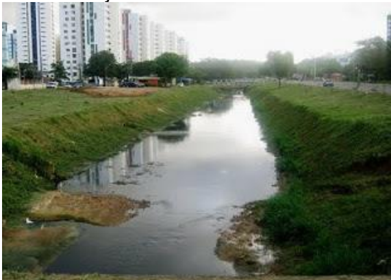
Figura 6.14 – Vista do Rio das Pedras – Antes da intervenção
