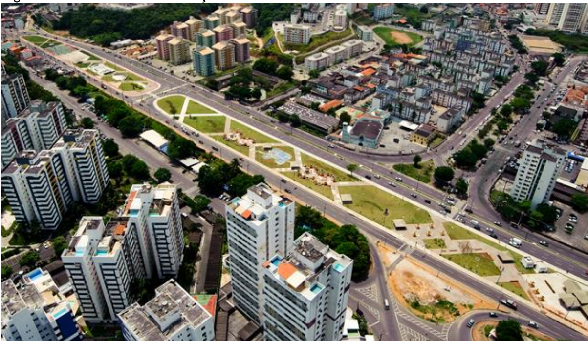
Figura 6.19 – Vista da urbanização do rio das Pedras no bairro do Imbuí
