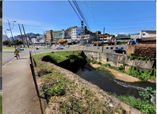
Figura 5.13 – Rio das Pedras – Vista da saída do trecho encapsulado e nas proximidades do Ponto de Coleta P06
