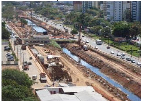
Figura 6.17 – Vista do Rio das Pedras – Durante a execução da obra
