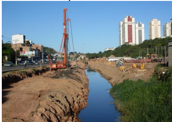
Figura 6.16 – Vista do Rio das Pedras – Durante a execução da obra
