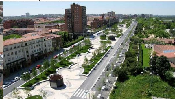
Figura 3.15 – Vista aérea de trecho de intervenção urbana do rio Manzanares, Madri/ Espanha
