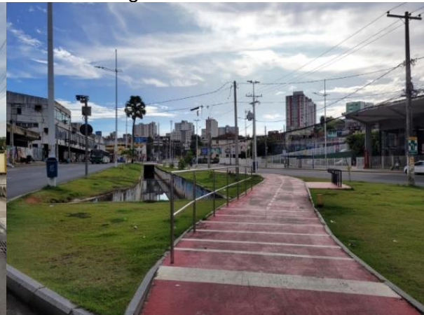
Figura 4.6 – Vista da requalificação urbana da Rua Cônego Pereira
