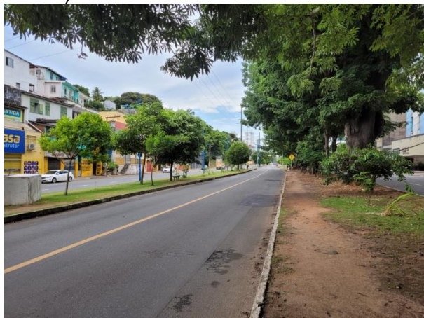
Figura 4.18 – Vista do corredor exclusivo de ônibus da Vasco da Gama (sobre o Rio Lucaia)
