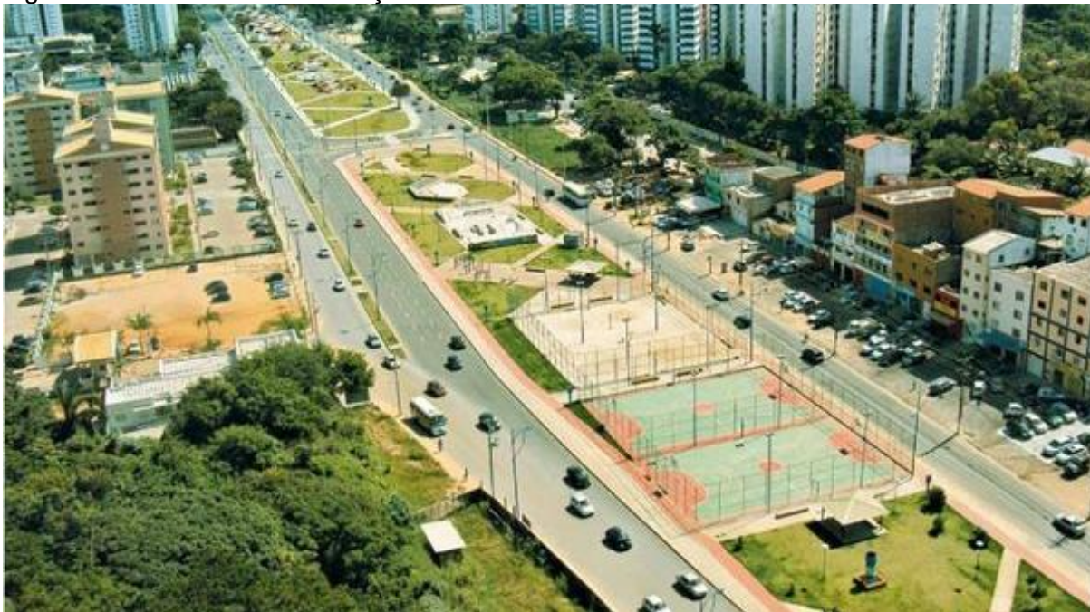
Figura 6.18 – Vista da urbanização do rio das Pedras no bairro do Imbuí
