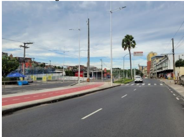
Figura 4.5 – Vista da requalificação urbana da Rua Cônego Pereira
