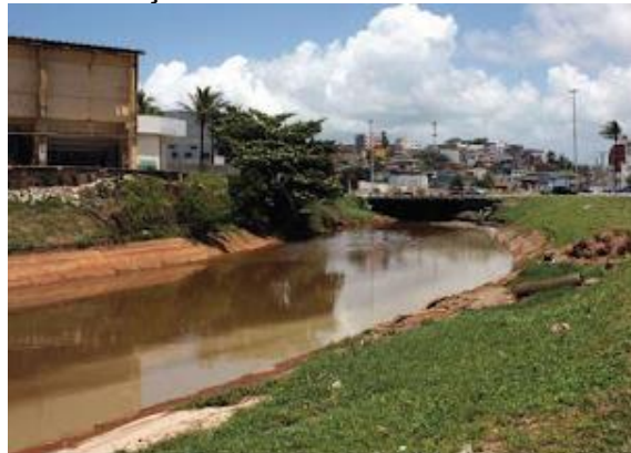
Figura 6.15 – Vista do Rio das Pedras – Antes da intervenção
