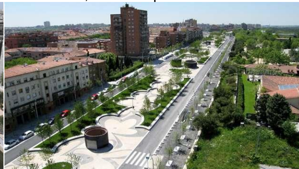
Figura 3.13 – Vista aérea de trecho de intervenção urbana nas proximidades do rio Manzanares, Madri/ Espanha
