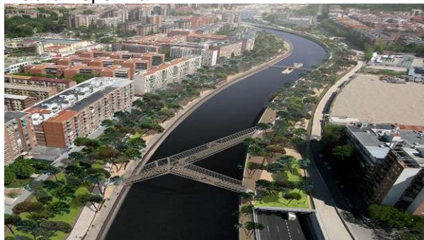
Figura 3.14 – Vista aérea de trecho de intervenção urbana do rio Manzanares, Madri/ Espanha
