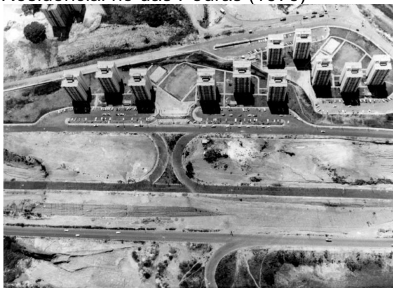
Figura 6.5 – Vista aérea do Conjunto Residencial rio das Pedras (1979)
