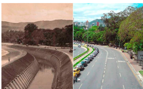
Figura 3.1 – Antes e depois da intervenção de tamponamento do rio Arrudas – Belo Horizonte / MG
