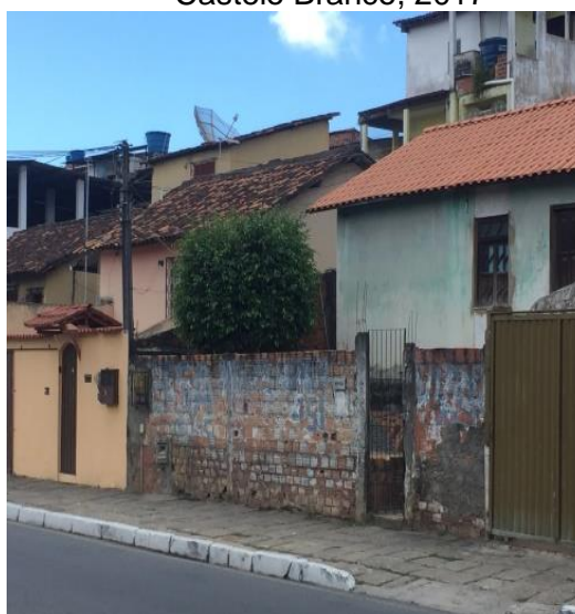
Figura 32 - Modelos das casas no início do conjunto habitacional Castelo Branco, 2017
