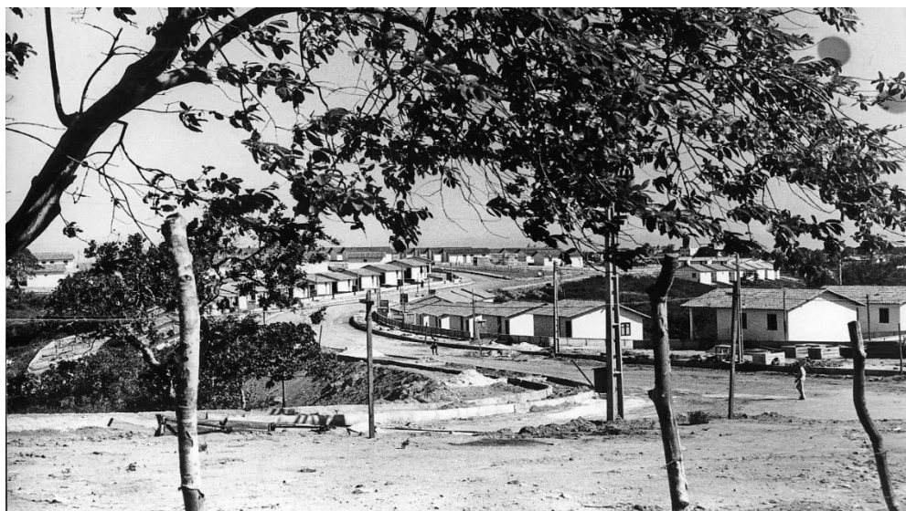
Figura 8 - Casas que integram a terceira etapa do bairro Castelo Branco entre 1972 – 1974
