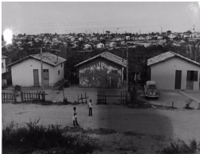
Figura 9 - Uso de material de baixa no acabamento das casas de Castelo Branco - 1983
