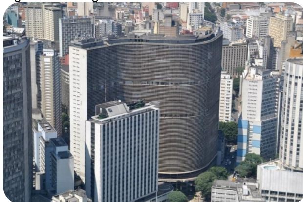
Figura 46 - Imagem contendo o Edifício COPAN em São Paulo
