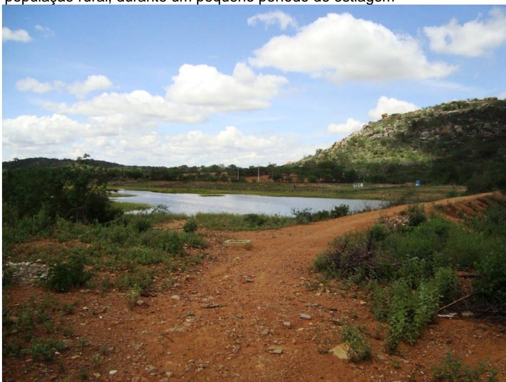
Figura 7 - Foto 6 - Reservatório de água (Açude) formado após período chuvoso. Essas barragens retêm água para suprir as necessidades dos animais e da população rural, durante um pequeno período de estiagem
