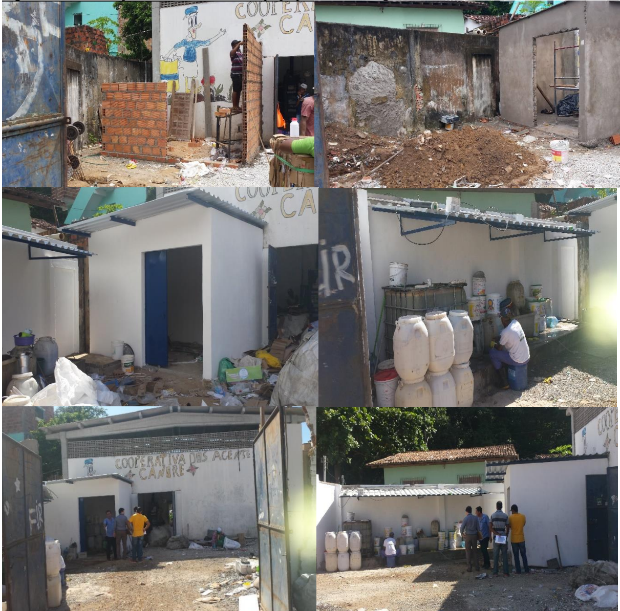
Figura 35 - Construção da casa do óleo e espaço para armazenagem em outubro e novembro de 2014
