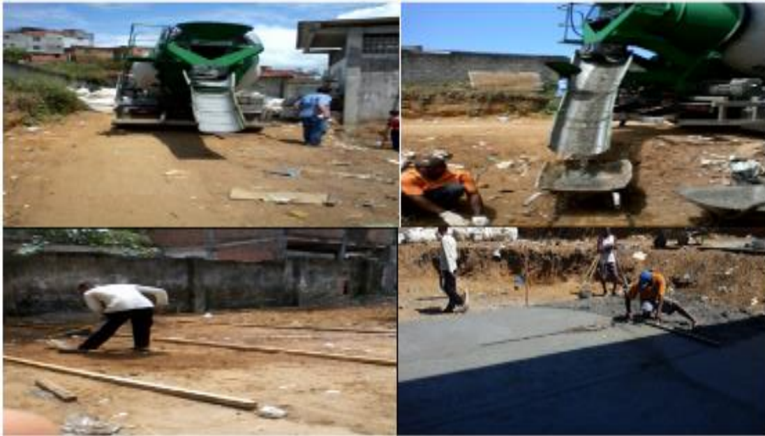
Figura 22 - Concretagem da área do fundo da CANORE em abril de 2014
