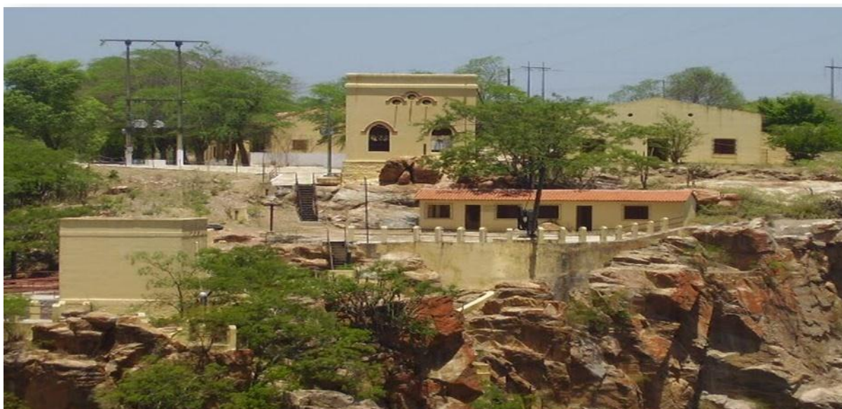
Figura 2 - Casa de força da 1ª Usina de Paulo Afonso
