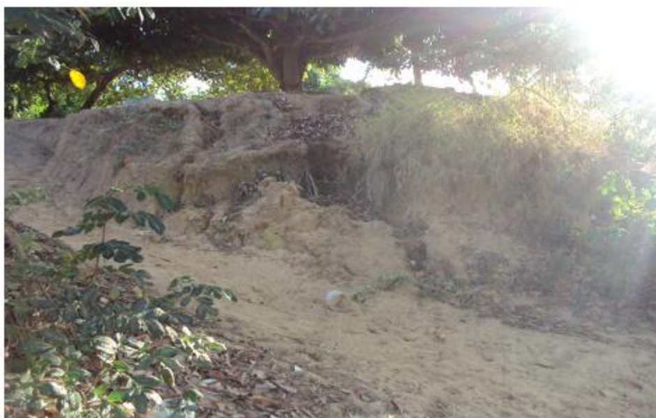
Figura 2 - Erosão na margem direita do rio São Francisco em Juazeiro no Submédio São Francisco
