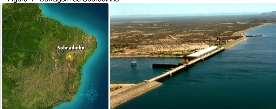
Figura 4 - Barragem de Sobradinho
