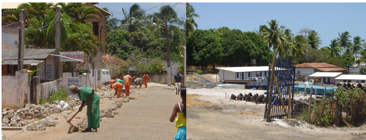
Figura 33 – Barra do Pojuca: obras de ampliação da rede de água em 28/10/2005
