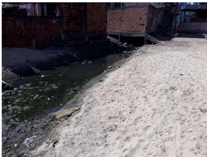
Figura 40 - Esgoto a céu aberto em Periperi, Salvador
