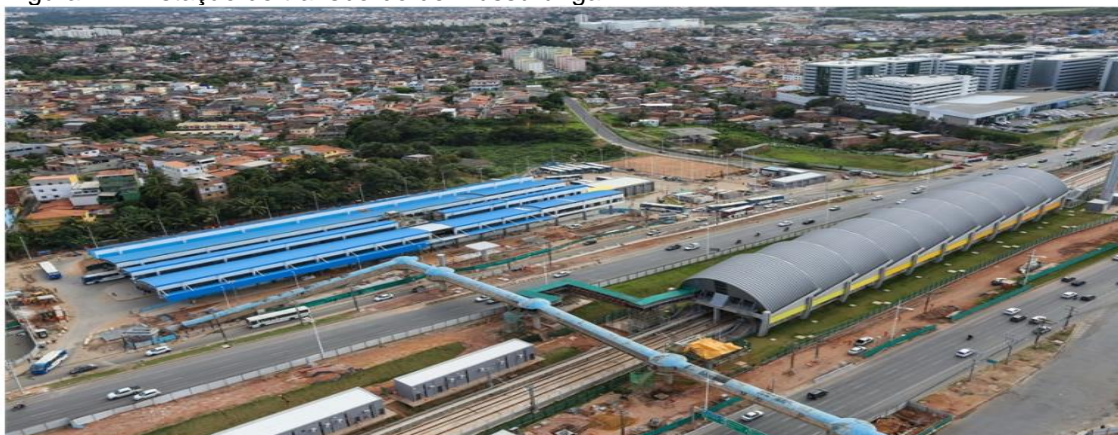
Figura 14 - Estação de transbordo de Mussurunga
