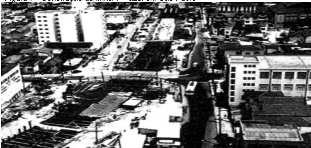
Figura 7 - Construção da linha 1 – azul em São Paulo
