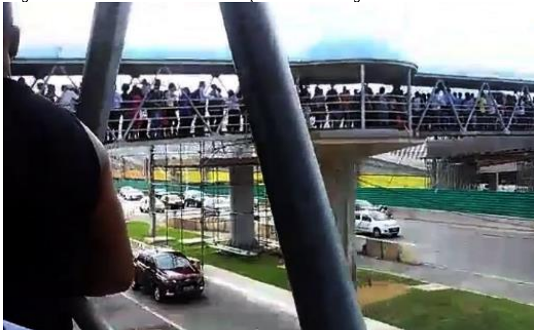
Figura 16 - Passarela de acesso à estação de Mussurunga
