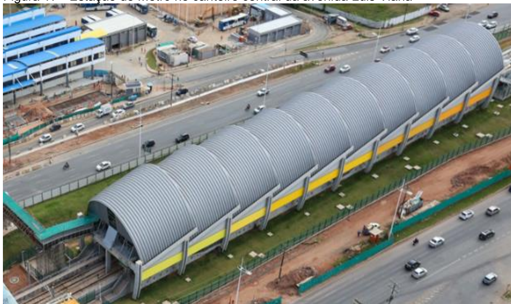
Figura 17 - Estação de Metrô no canteiro central da avenida Luis Viana
