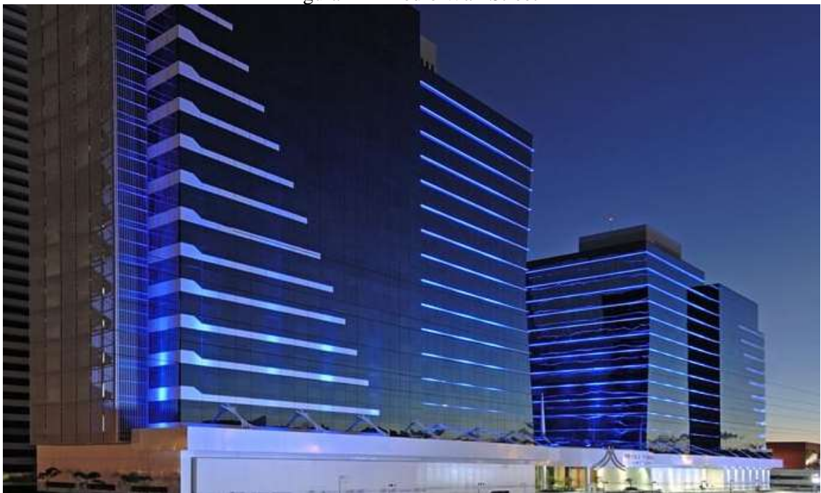
Figura 42 - Prédio Wall Street
