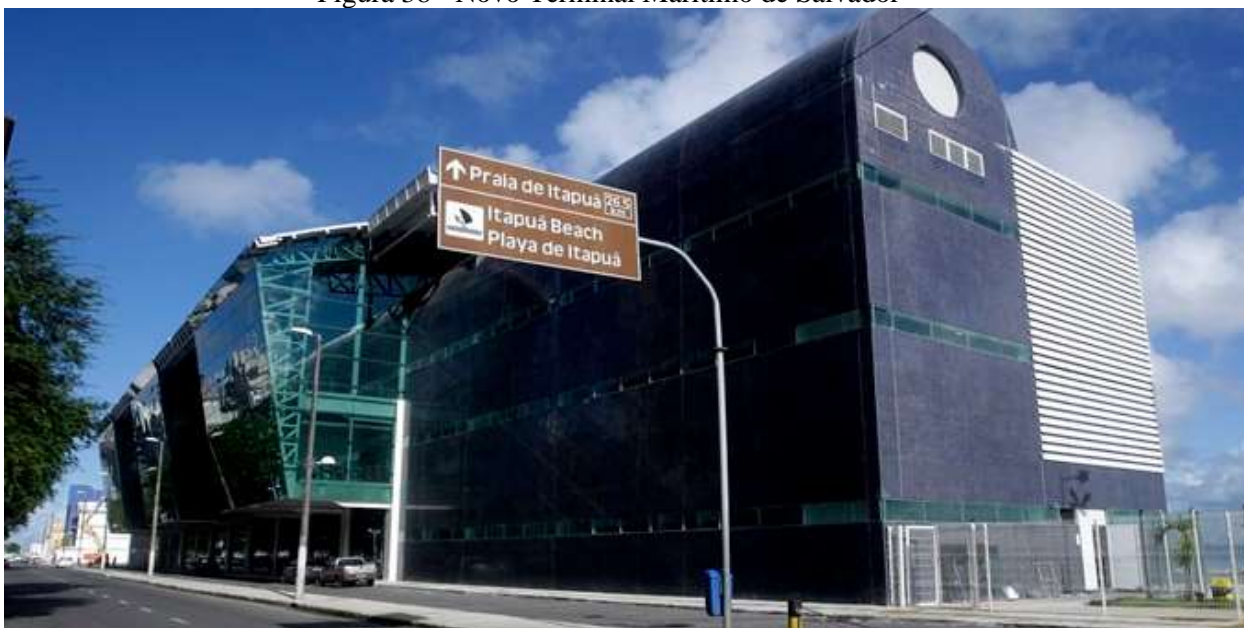
Figura 38 - Novo Terminal Marítimo de Salvador
