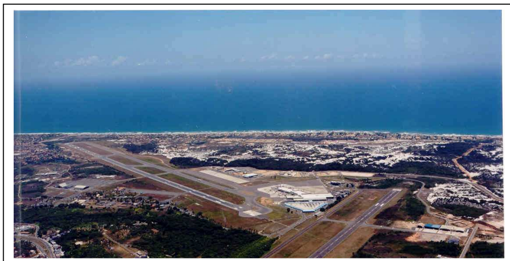
Figura 10 - Vista Aérea do Complexo Aeroportuário de Salvador Fonte: Infraero (2007).
