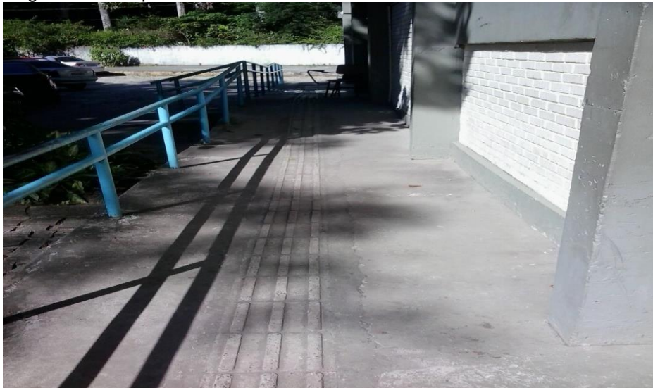
Figura 4 – Rampa de acesso à entrada lateral/CAS-BA/2016
