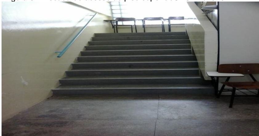
Figura 5 – Escada de acesso ao piso superior/CAS-BA/2016.
