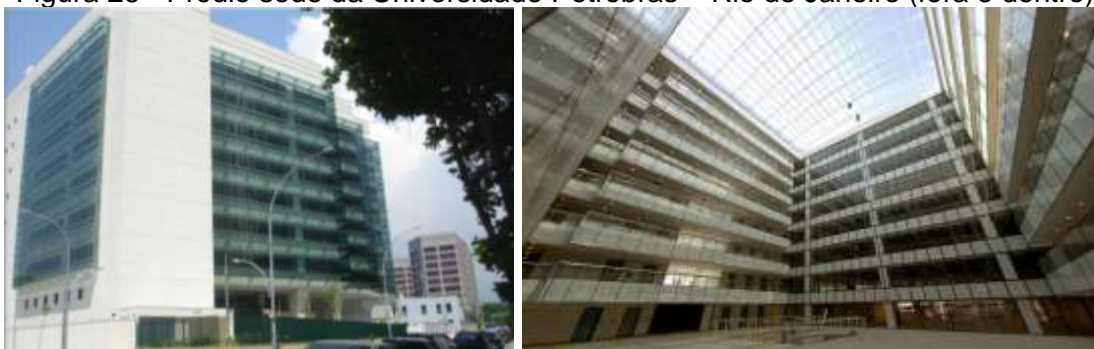
Figura 26 - Prédio sede da Universidade Petrobras – Rio de Janeiro (fora e dentro)
