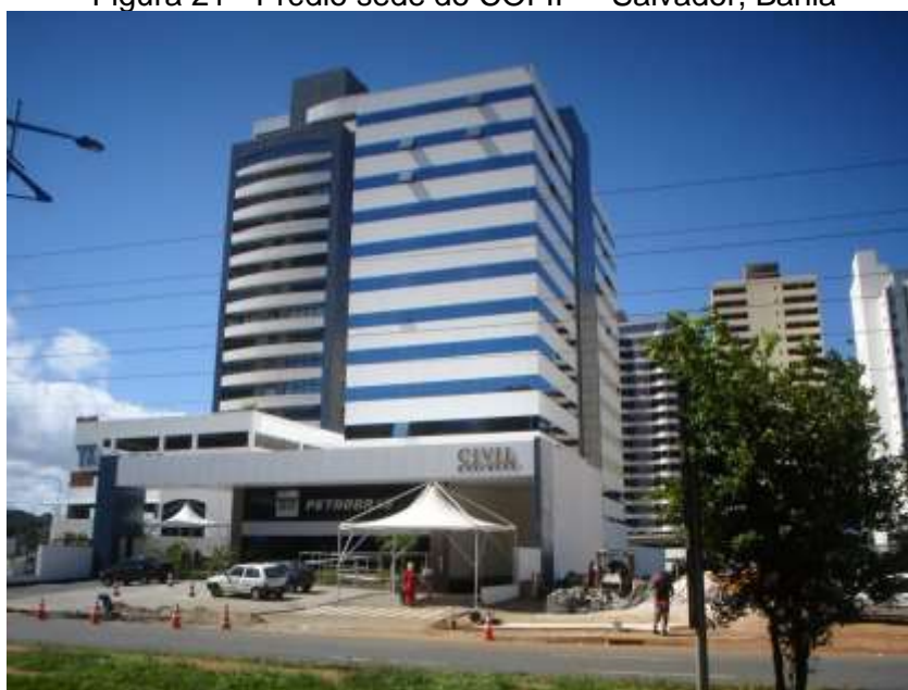
Figura 21 - Prédio sede do COFIP – Salvador, Bahia
