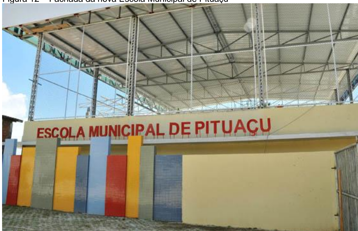
Figura 12 – Fachada da nova Escola Municipal de Pituaçu
