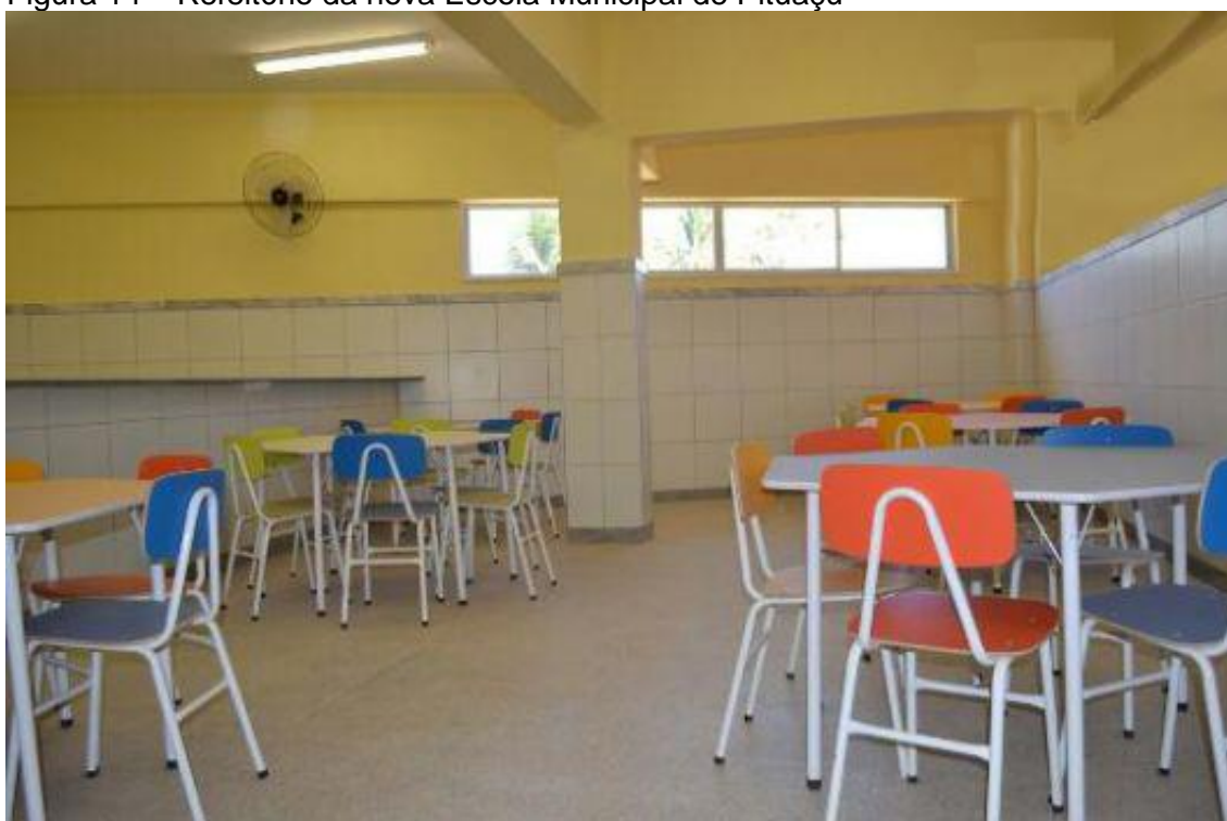
Figura 14 – Refeitório da nova Escola Municipal de Pituauçu
