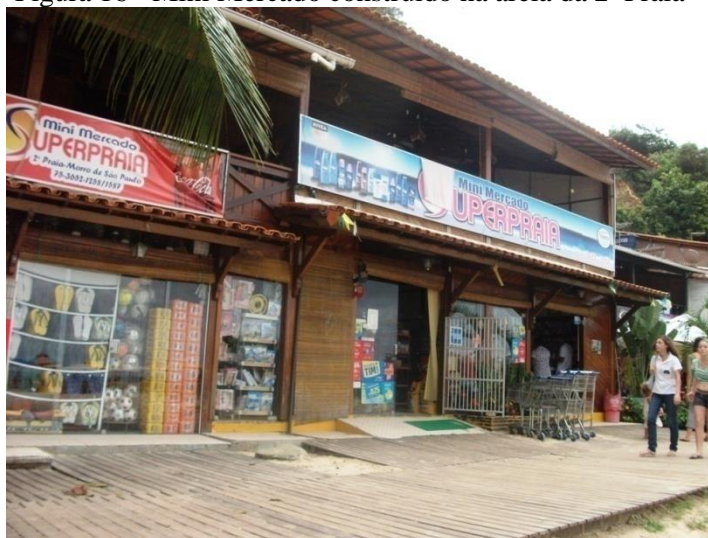
Figura 16 - Mini Mercado construído na areia da 2ª Praia
