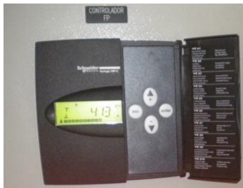
Figura 6.14 – Corrente em um dos painéis DAS durante operação, após a ativação dos estágios do banco de capacitores
