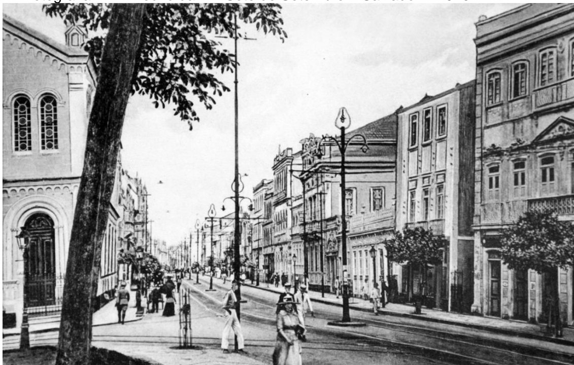
Fotografia 11 – Trecho da Av. Sete de Setembro – Salvador – 1920*
