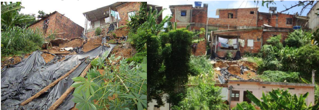
Figura 12 – Tipologia de imóveis – Encosta de Pirajá
