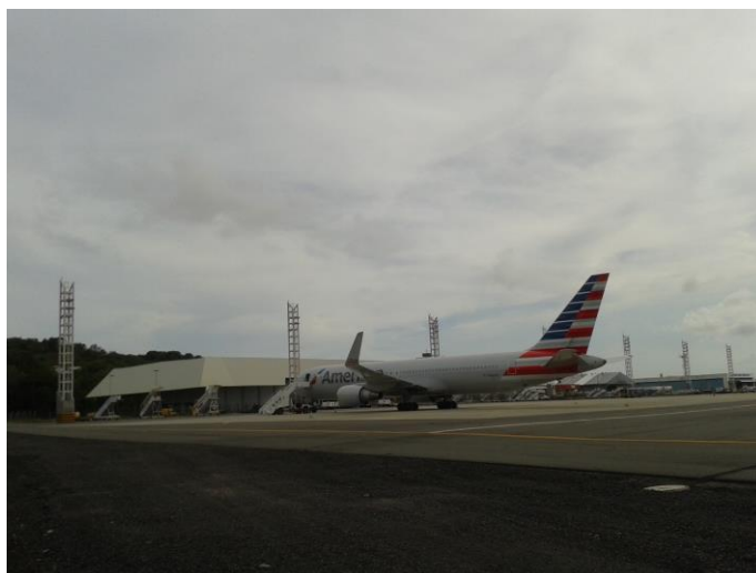
Figura 7.23 - Iluminação Pátio 3 com Luminárias Específicas com lâmpadas V Metálico ovóides de 1.000W
