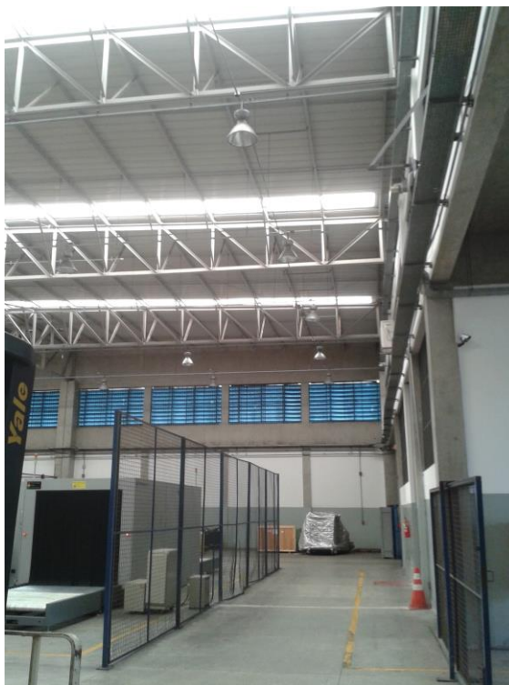
Figura 4.2 -Iluminação de Terminal de Cargas lâmpadas de multivapores metálicos de 400W
