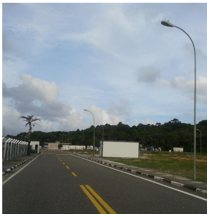
Figura 7.16 - Iluminação das Vias de Acesso próximas ao TECA; com Luminárias Publicas com lâmpadas a vapor de sódio 250 W
