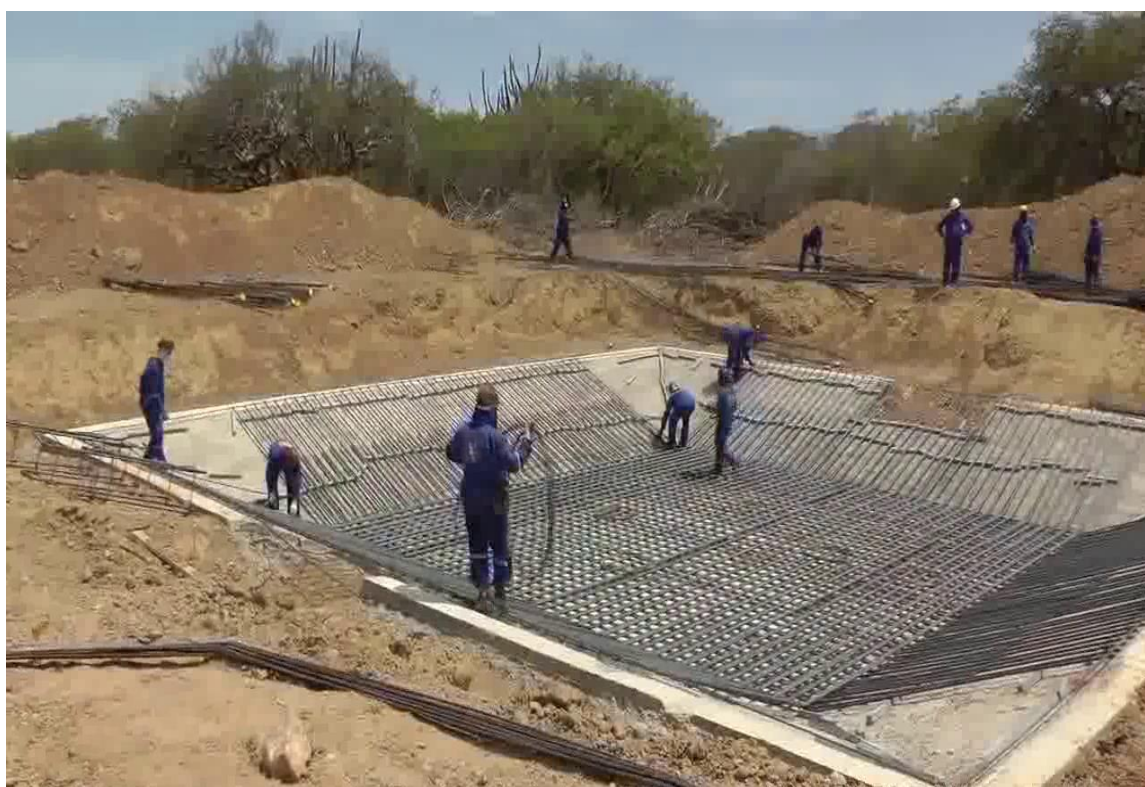
Figura 17 - Pavimentação do solo para a implantação de aerogerador dentro da Área de Proteção Ambiental: Lago de Sobradinho no município de Casa Nova
