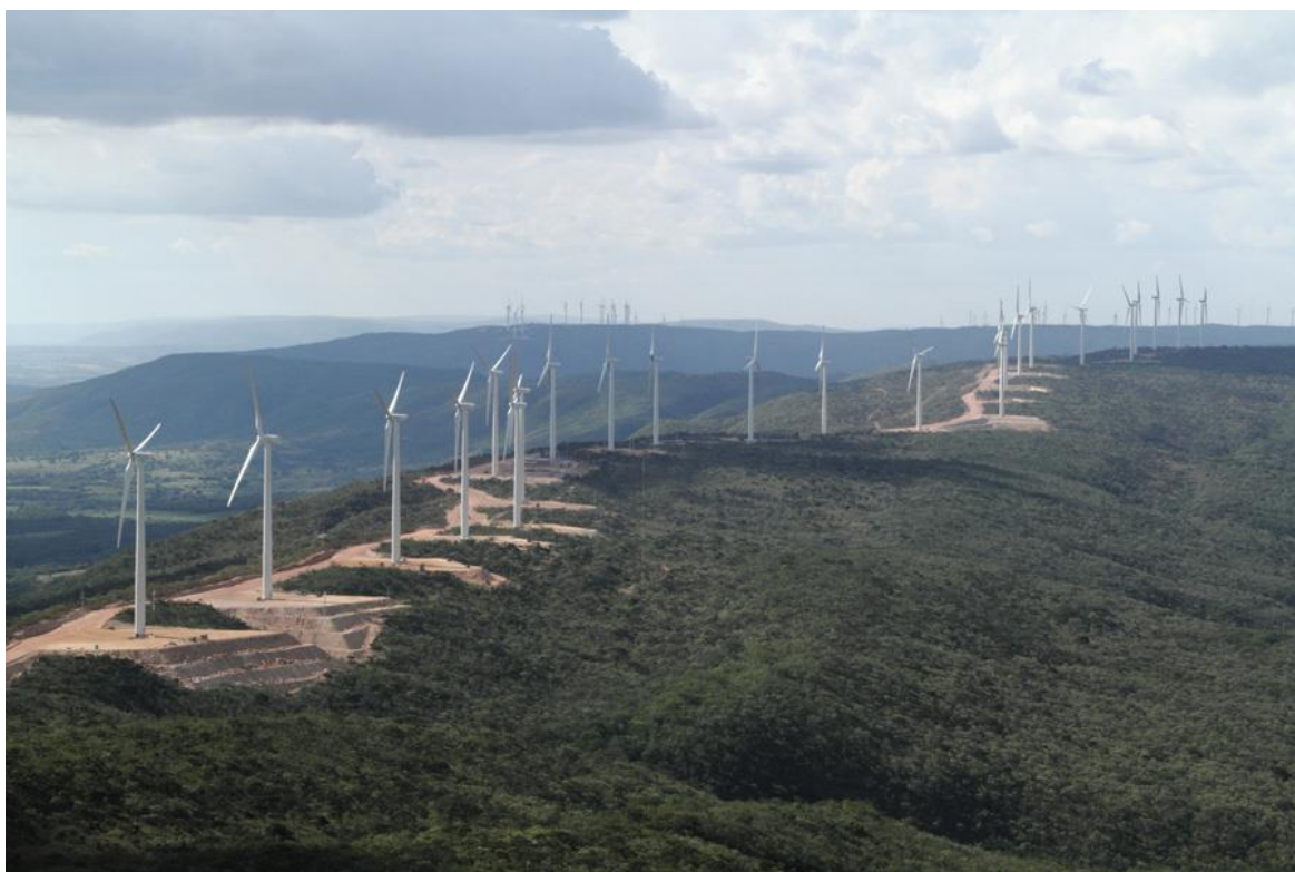
Figura 28 - Aerogeradores ociosos do Parque Eólico Alto Sertão 1, no município de Caetitê no Estado da Bahia, em dezembro de 2013
