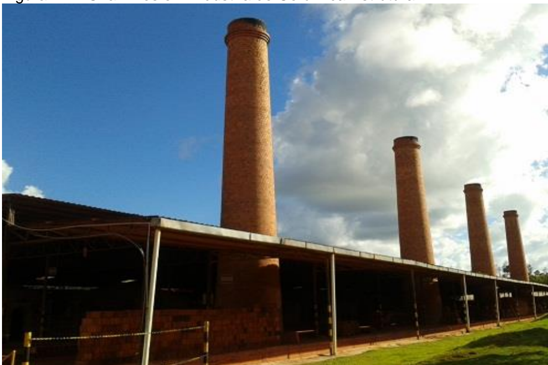
Figura 12 – Chaminés em Indústria de Cerâmica Estrutural
