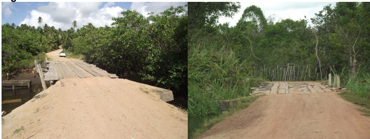
Figura 60 – Pontes na estrada Barra do Itariri – Linha Verde
