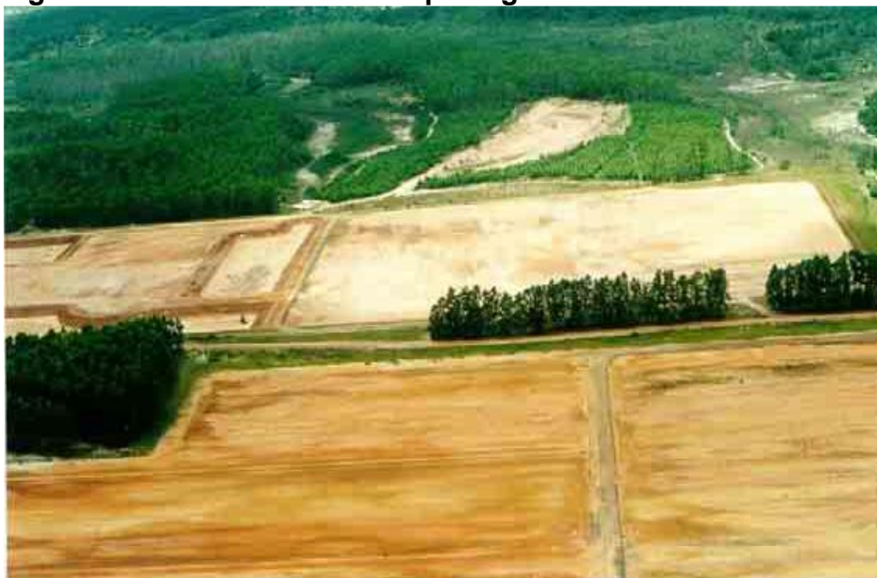
Figura 36 – Foto aérea da terraplenagem da Norcell Celulose
