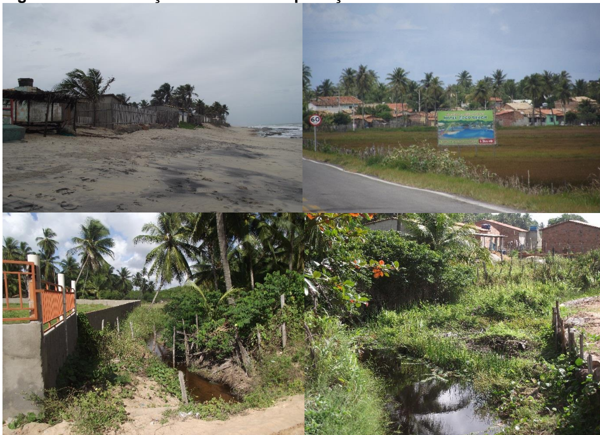
Figura 76 – Construções em zonas de proteção
