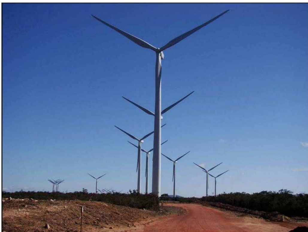
Acessos internos no Complexo Eólico da Desenvix – Brotas de Macaúbas - BA Fonte: Ângelo Brasileiro, 31/10/2011.
