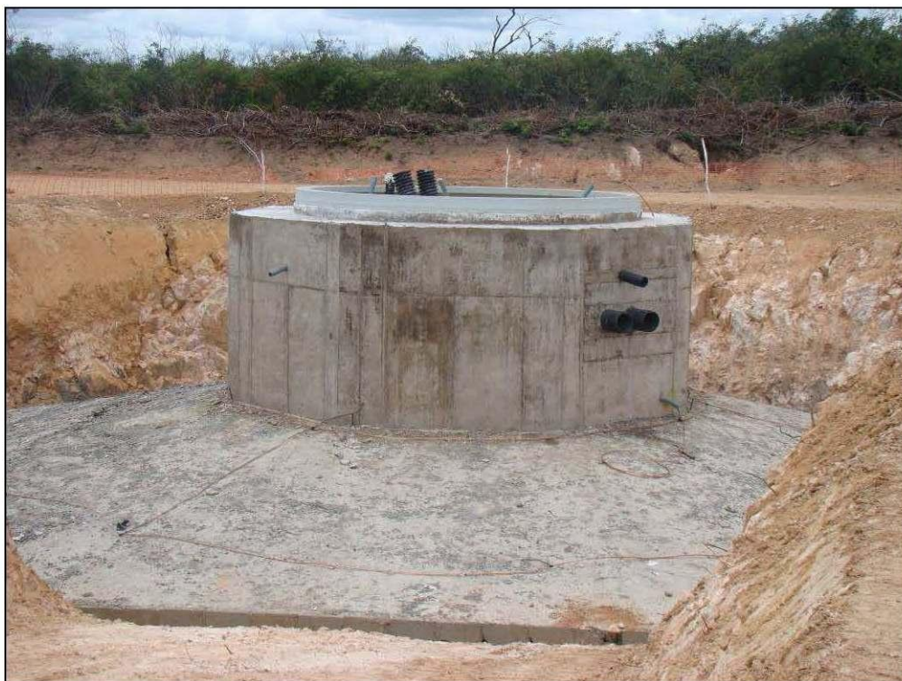
Base de sustentação das torres semi-pronta 15m X 15 m Fonte: Fabiano Staut, 15/02/2011.
