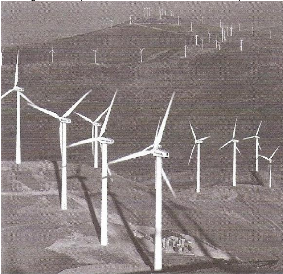
Figura 8 - Parque Eólico em terreno com declive na Espanha
