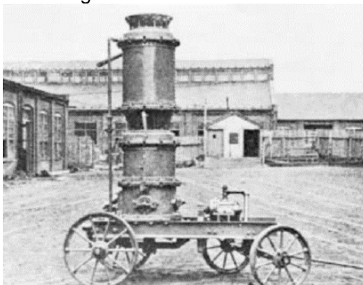
Figura 6 - Bomba utilizada para cobrir fachada no museu de Chicago em 1907
