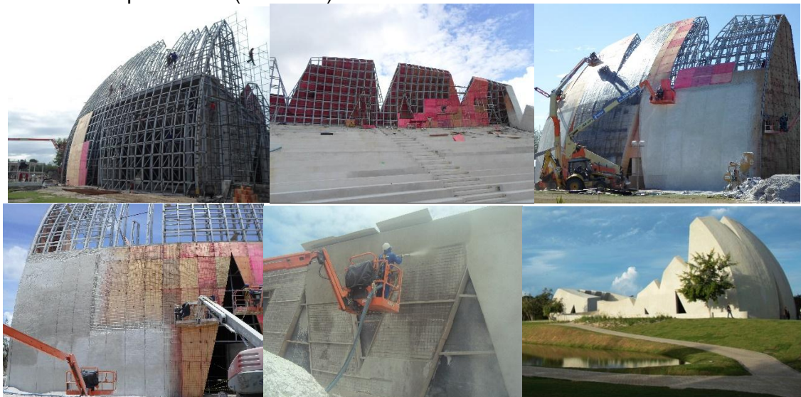
Figura 17 - Painel 6 – Estrutura metálica suportando o madeirite em superfície curvilínea [curvilíneas côncava (externo) e convexa (interno)]; detalhes de suporte ao fechamento perimetral da arquibancada (shotcrete) e lateral concluída
