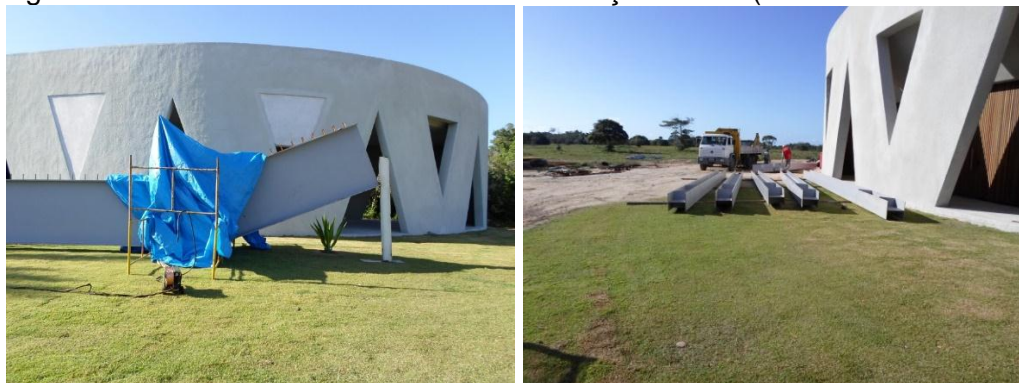
Figura 10 - Painel 3 - Vista externa da construção anexa ( Facilities )
