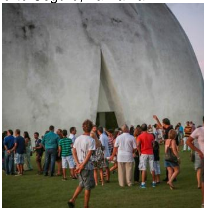
Figura 20 - Escurecimento na superfície externa do alvenaria estruturante do Teatro L'Occitane, no distrito de Trancoso, em Porto Seguro, na Bahia
