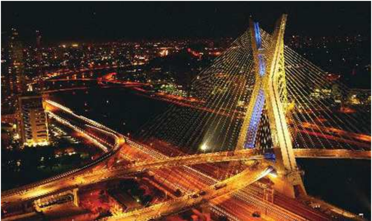
Figura 3 – Foto da Ponte Estaiada de São Paulo-SP Fonte: Ecoatividade (2010).
