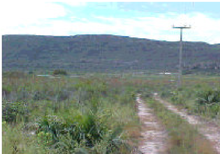
Foto 5 – Acesso próximo a EMBASA e a LD 34,5 kV existente
