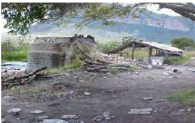
Foto 9 – Olaria nas proximidades da área alagável
