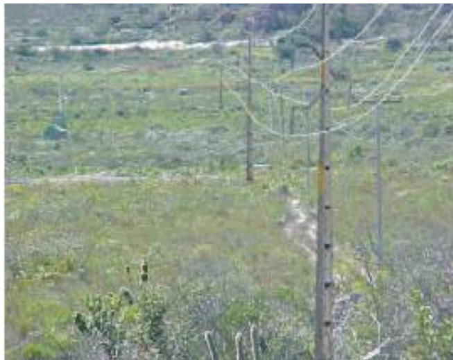
Foto 13 – Visão da via de acesso existente
