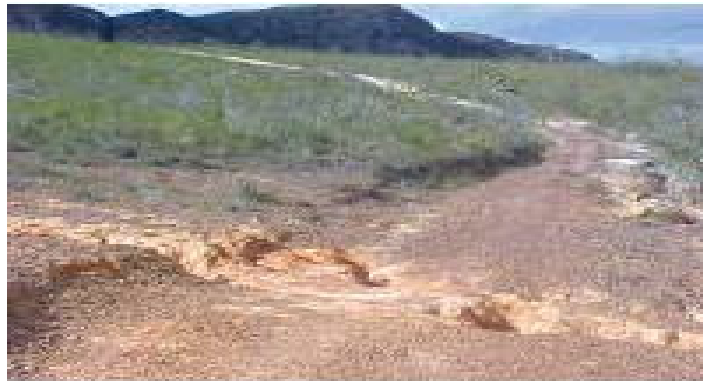
Foto 10 – Processos erosivos em via de acesso existente
