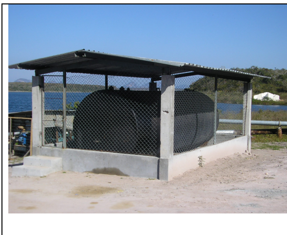
Foto 3 - Reservatório de Óleo Diesel às Margens da Barragem do Apertado
