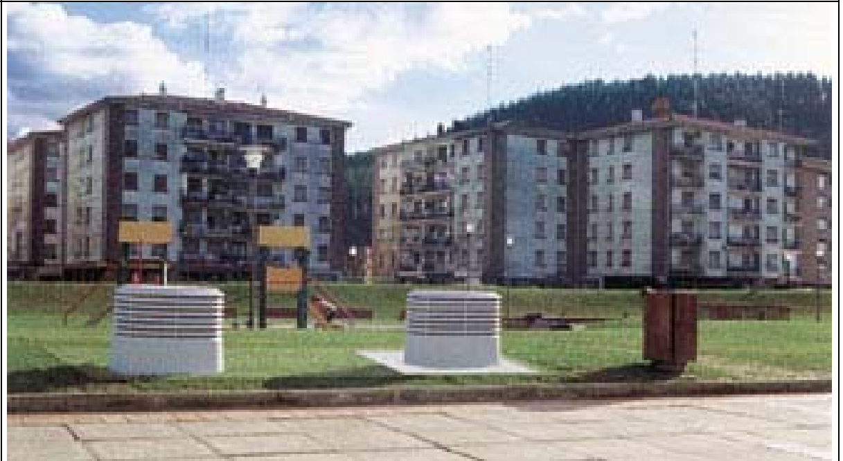
Figura 25: Foto de um centro de transformação compacto 150 kVA. Fonte www.ormazabal.com.br
