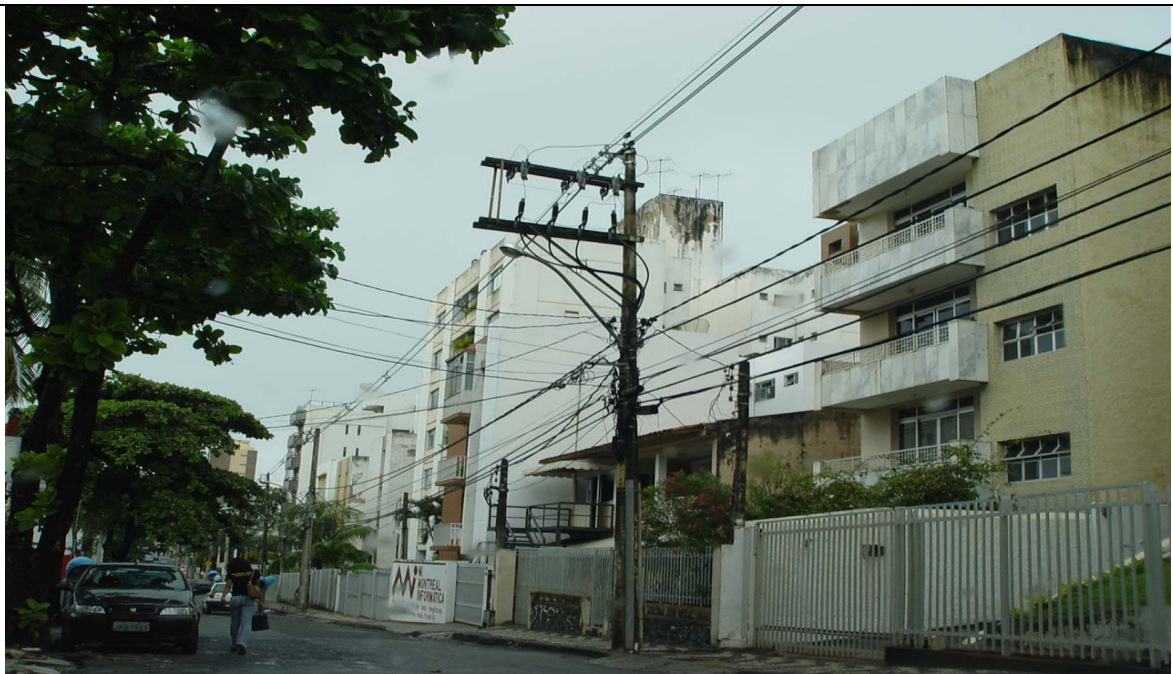
Figura 29: Bairro de Itapuã em Salvador BA. A linha compacta em área não arborizada. Fonte AGERBA.
