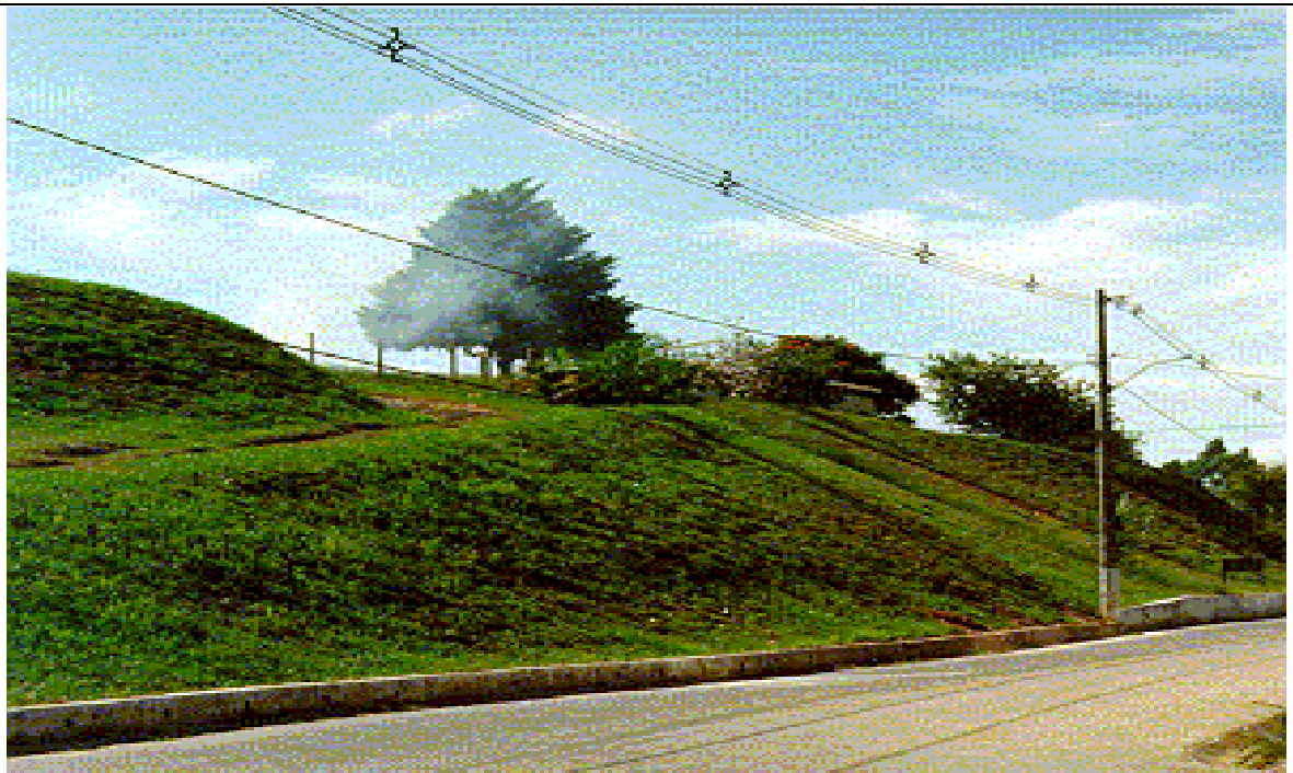
Figura 10: Exemplo de condomínio residencial com rede compacta. Fonte www.inbrac.com.br .
