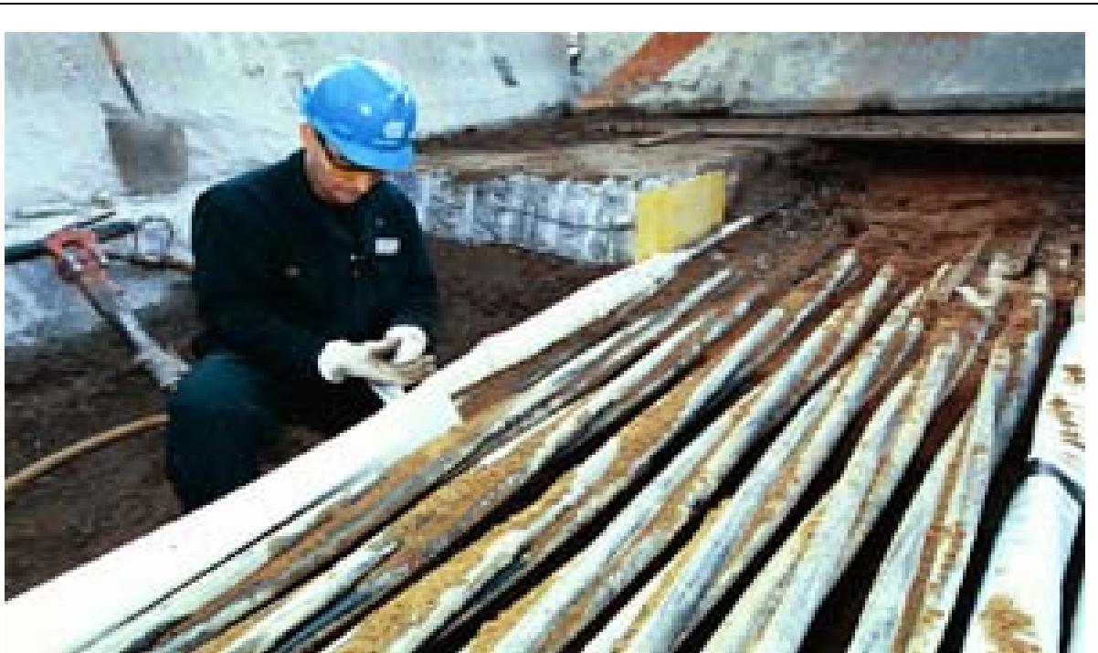
Figura 35: NY. Operário reconstrói as linhas subterrâneas que alimentavam o WTC. Fonte NYCH.
