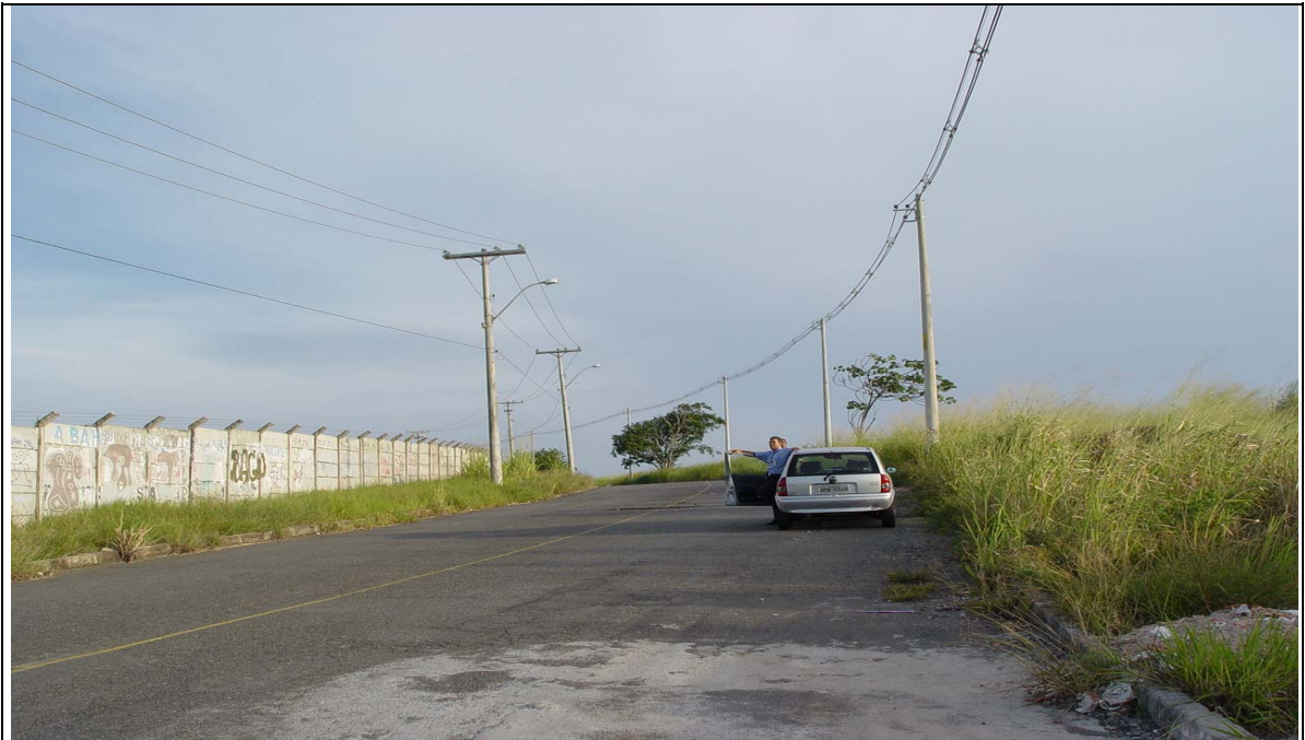
Figura 29: Bairro de Itapuã em Salvador BA. A linha compacta em área não arborizada. Fonte AGERBA.
