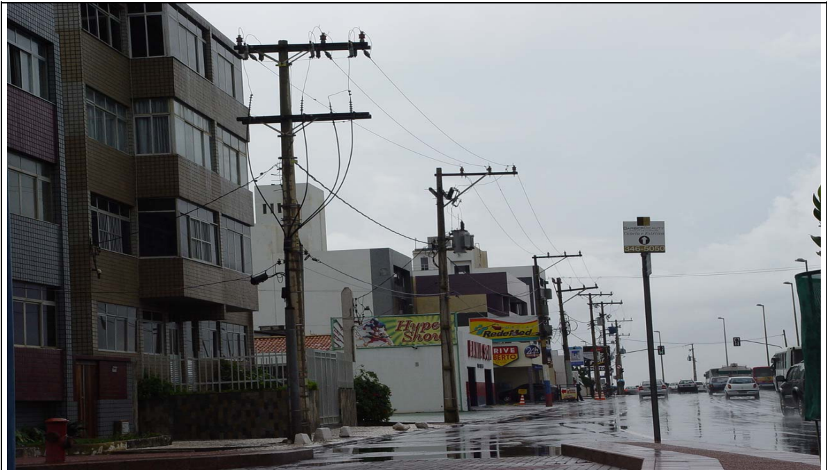
Figura 27: Av. Oceânica em Salvador. O salitre impede a instalação de redes compactas. Fonte AGERBA
