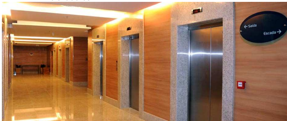
Figura 18 - Corredor de acesso aos apartamentos do Mundo Plaza, sem presença de sinalização e piso tátil de alerta, de alerta sonoro e de painel em braile nos elevadores
