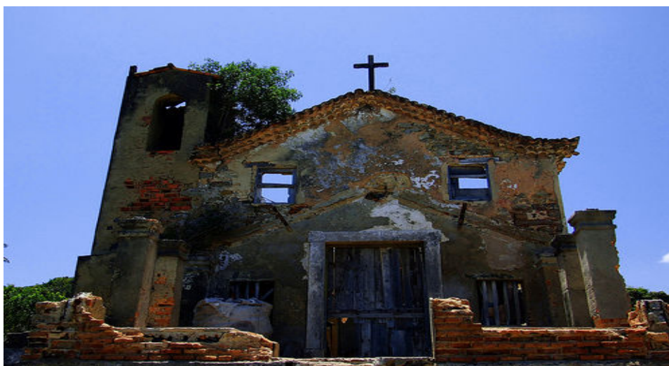
Figura 27 - Ruínas da Igreja de Santo Antônio dos Velasques - Vera Cruz Bahia
