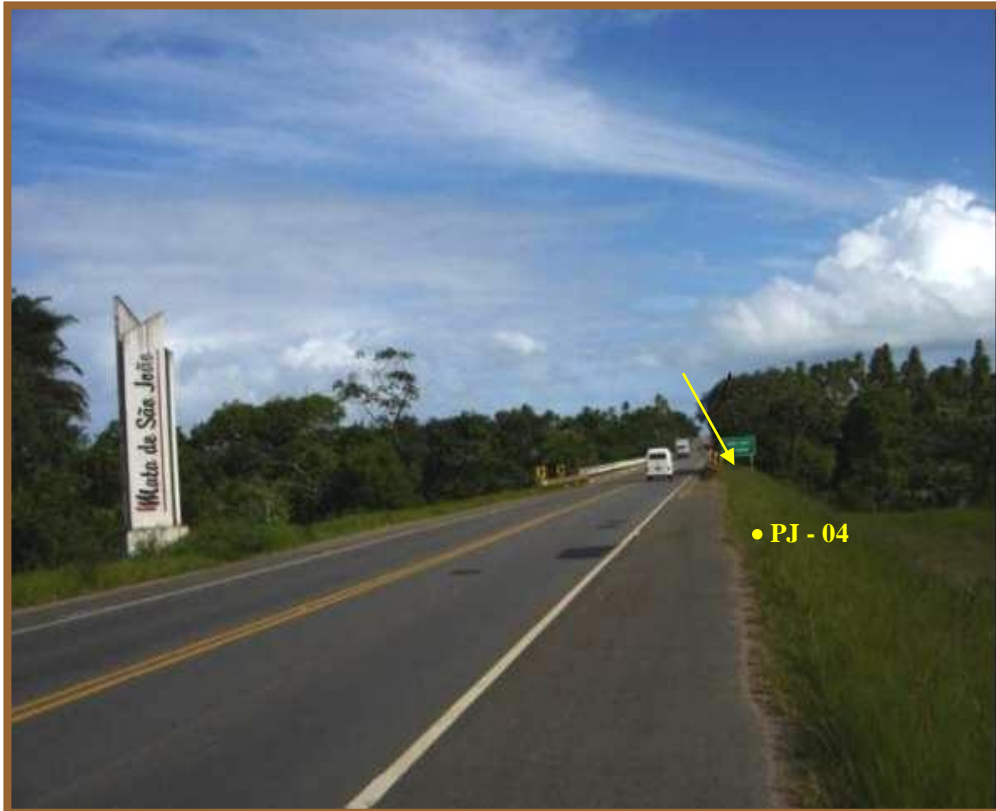
Figura 15 - Ponte sobre o Rio Pojuca
