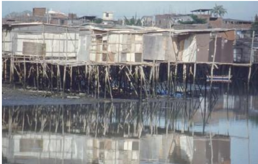
Figura 18 – Palafitas dos Alagados
