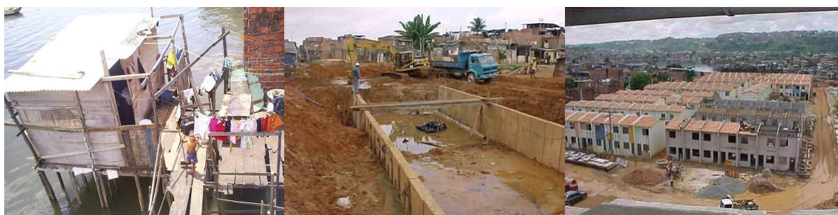
Figura 19 – Intervenções físicas na área
