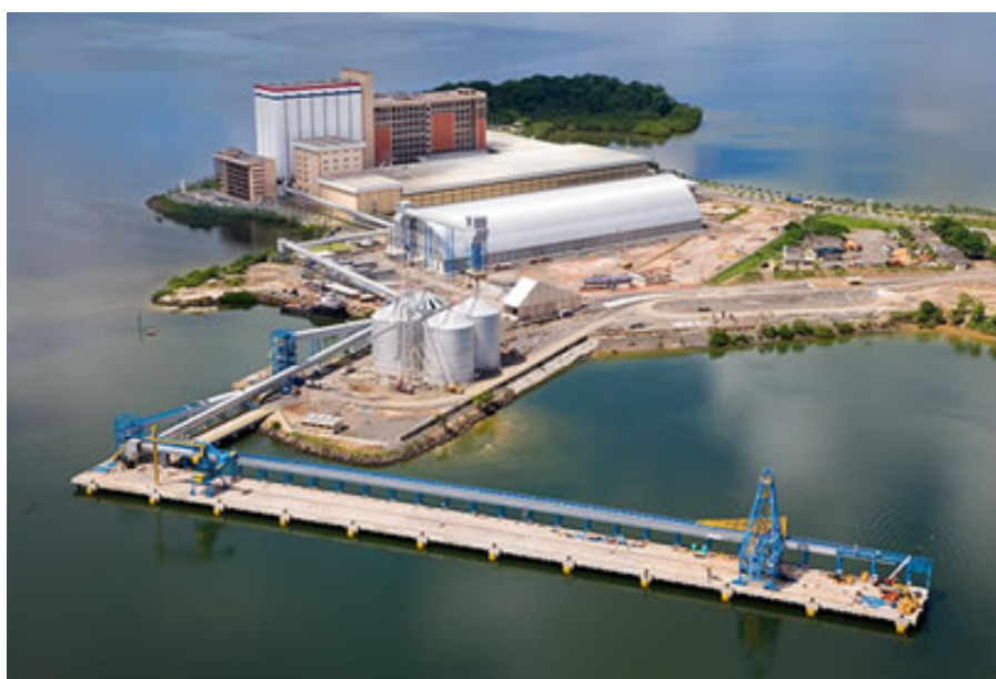
Figura 11 - Porto de Cotegipe – C. Port, localizado no canal de Itapagipe Fonte: Grupotpc (2008).
