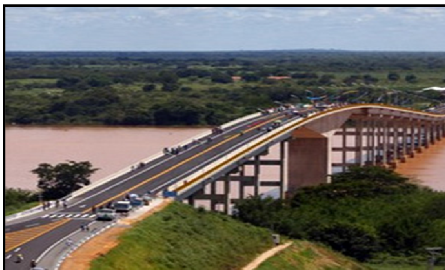
Fotografia 1 – Ponte entre os municípios de Carinhanha e Malhada - Bahia-2010
