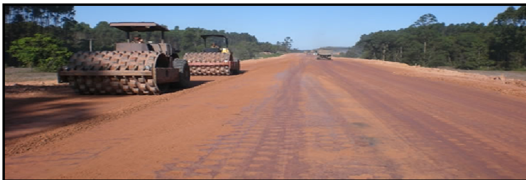
Fotografia 2 – Construção e pavimentação da BR- 418/BA (Caravelas – Entroncamento com a BR-101/BA) pelo Exército Brasileiro – Bahia-2010
