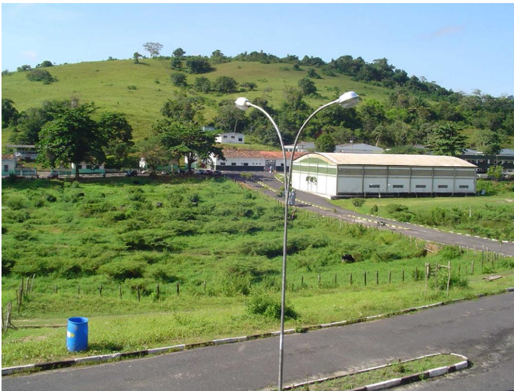
Figura 39– Vista parcial do IF Baiano Campus Catu
