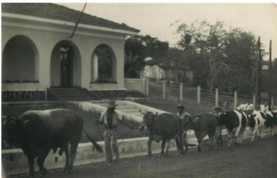
Figura 31 – Residência para servidor – 1918-1960 - IF Baiano campus Catu
